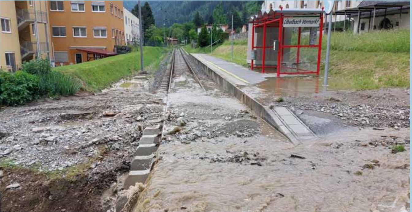
Abb. 5: Unterspültes Bahngleis aufgrund der Ausuferung Köppelbach © WLV
