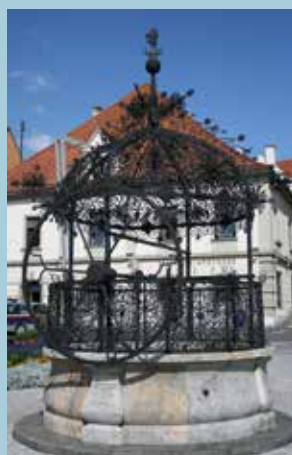
Abb. 4: Der „Eiserne Brunnen“ in Bruck an der Mur im Jahr 2015 © Reismann
