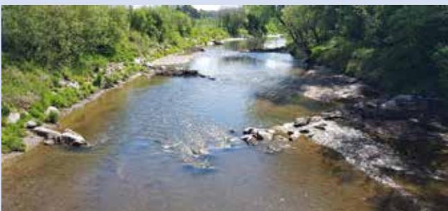
Abb. 3: Inklinant angeordnete Lenkbuhnen aus Bruchsteinen bei Niederwasser (links) und bei erhöhter Mittelwasserführung (rechts). Durch die serielle Anordnung der Buhnen im Außenbogen wird der Stromstrich in Richtung Gewässermitte geleitet, womit eine Entlastung der Pralluferböschung einhergeht. HWS Neue Kainach, Dobl-Zwaring © IB Parthl
