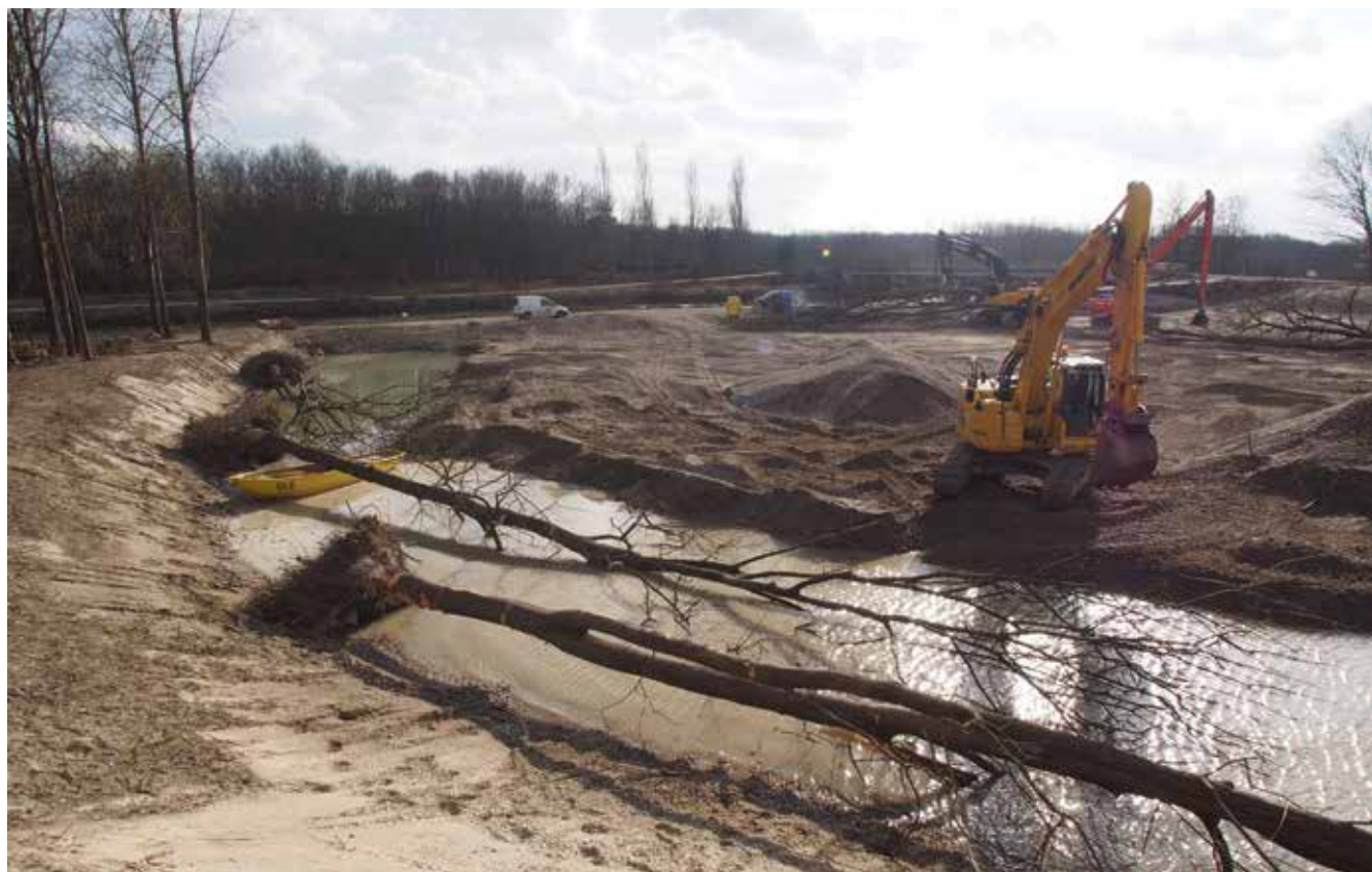
Abb. 10: Mit Erdankern befestigte Raubäume im neuen Bett der Traisen (NÖ) © ezb
