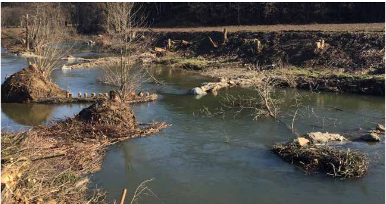
Abb. 7: Aufweitung des Gewässerbettes unter gleichzeitiger Einbringung von Strukturelementen wie Strömungsteilern, Bühnen und zahlreichen Biotopholzstrukturen – Sulm (Mantrach) kurz nach Fertigstellung © A14/Ambrosch
