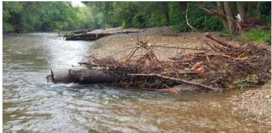
Abb. 8: Schrägverplockte ausschlagfähige Stammhubne mit angelandetem Geschwemmel, „Neue Kainach“ Dobl-Zwaring. Angeschwemmtes Holz ist hocherwünscht und erhöht u. a. die strukturelle Vielfalt © IB Parthl
