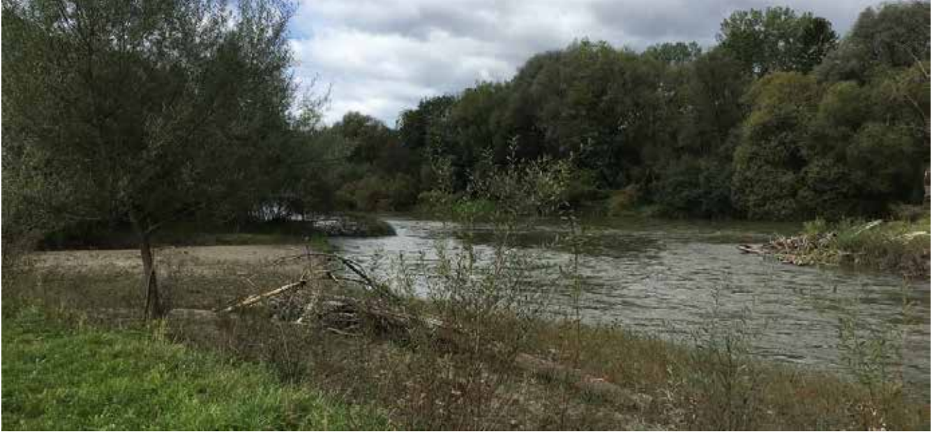
Abb. 6: Neuerrichtung eines Nebenarms an der oberen Mur im Rahmen des LIFE-Projektes © A14/Ambrosch
