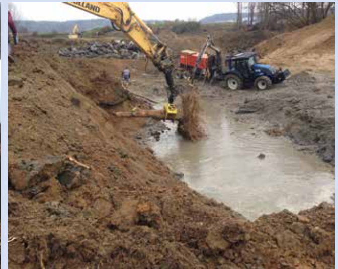
Abb. 31: Einbringen von Astlagen und anstehendem Bodenmaterial in Schichten bis zum Erreichen der Böschungshöhe. Nach dem Auflegen der Äste mit dem Bagger werden diese händisch ausgerichtet © IB Parthl
