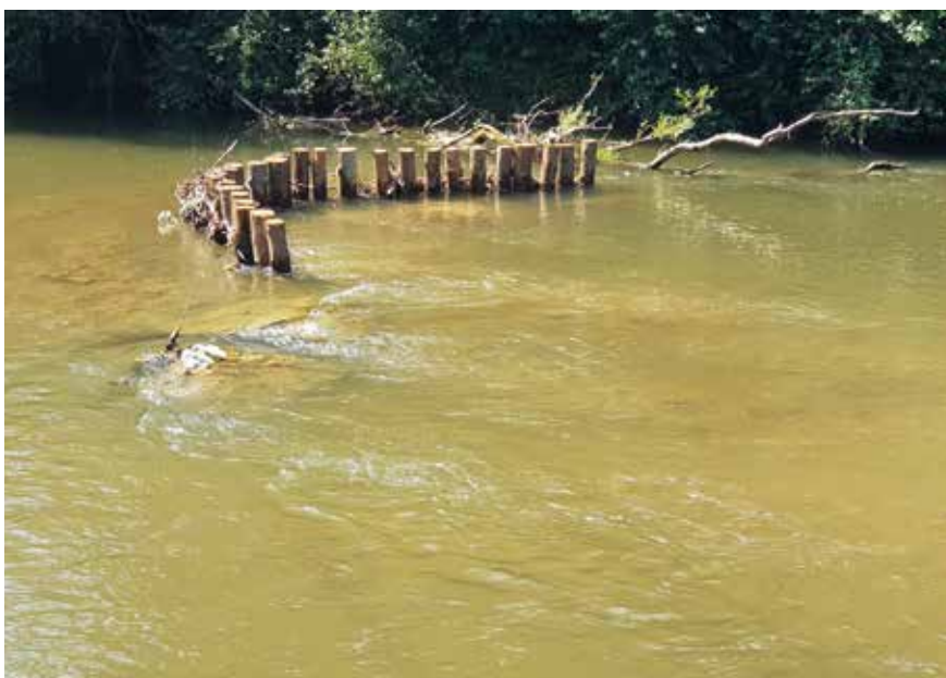
Abb. 13: Sichelförmige Anordnung von Lärchenpiloten. Die Maßnahme bietet flussab der Pilotenreihe strömungsberuhigte Bereiche © IB Parthl
