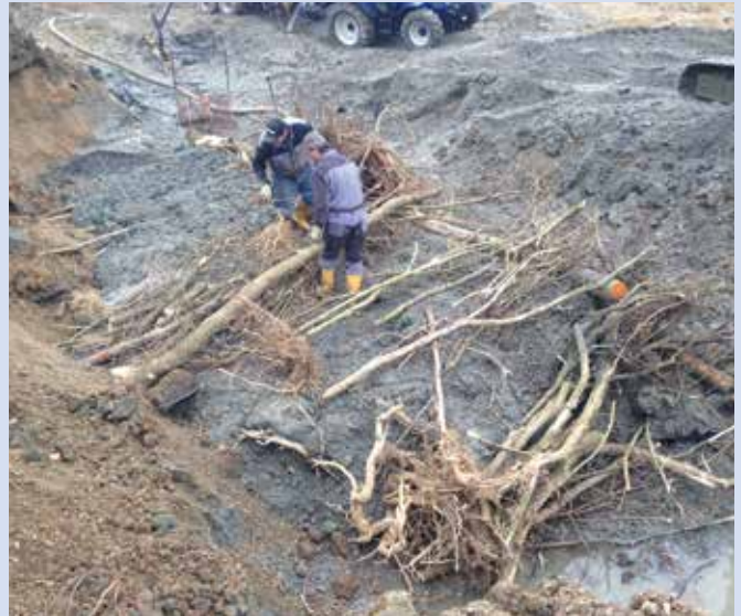
Abb. 30: Maschinelles Einlegen von Biotopholz und ausschlagfähigen Gehölzen (Raab Hohenbrugg/Welten) © IB Parthl
