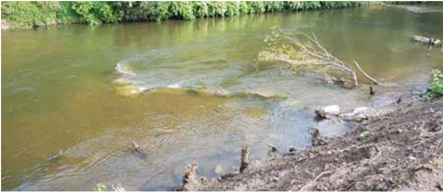
Abb. 4: Rechtsufrig angeordnete Hakenbuhne aus Bruchstein, Sulm/Leibnitz © IB Parthl
