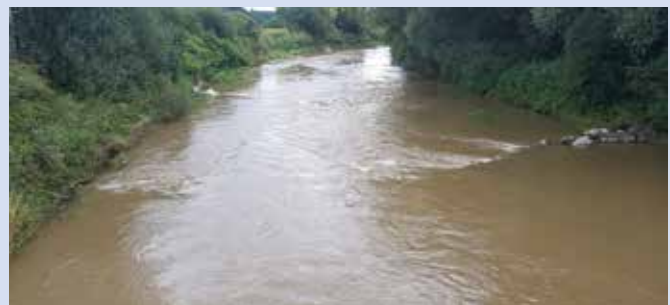
Abb. 3: Inklinant angeordnete Lenkbuhnen aus Bruchsteinen bei Niederwasser (links) und bei erhöhter Mittelwasserführung (rechts). Durch die serielle Anordnung der Buhnen im Außenbogen wird der Stromstrich in Richtung Gewässermitte geleitet, womit eine Entlastung der Pralluferböschung einhergeht. HWS Neue Kainach, Dobl-Zwaring © IB Parthl
