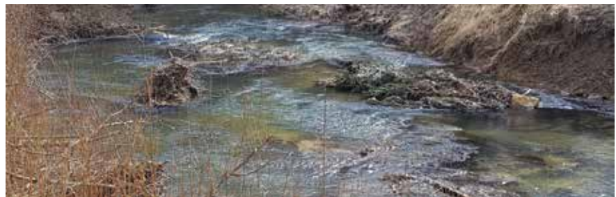
Abb. 21: Raubäume zur Strukturierung der Uferböschungen, Sulm/Gleinstätten © IB Parthl
