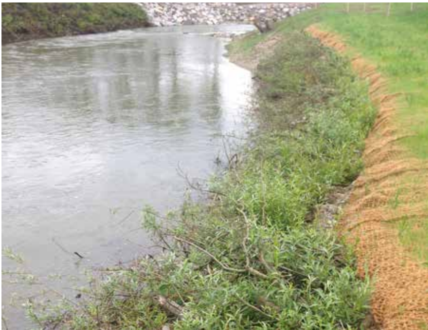
Abb. 27: BMU im rechten Altarm; wenige Monate nach Einbau ist das ausschlagfähige Material bereits sehr gut angewachsen © IB Parthl
