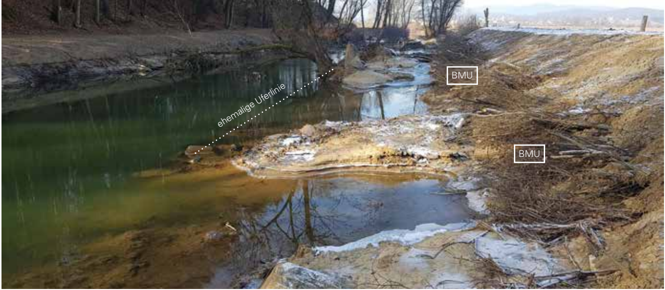
Abb. 24: Aufgeweiteter und sohlstrukturierter Sulmabschnitt flussab Gleinstätten. Gut sind die BMU und die ehemalige Uferlinie zu erkennen © IB Parthl
