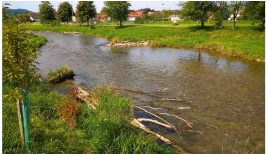
Abb. 2: Wechselseitige Buhnen/Raubaubuhnen verbessern die Struktur von Ufer und Sohle und fördern variable Strömungs- und Substratverhältnisse, Pielach bei Hofstetten (NÖ) © ezb
