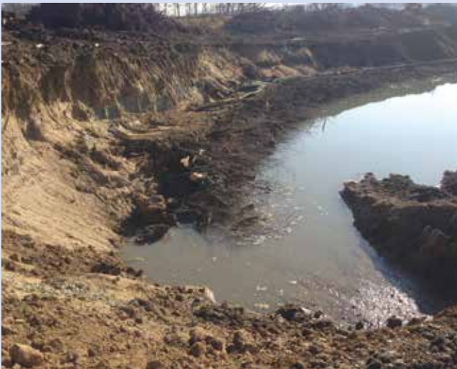
Abb. 31: Einbringen von Astlagen und anstehendem Bodenmaterial in Schichten bis zum Erreichen der Böschungshöhe. Nach dem Auflegen der Äste mit dem Bagger werden diese händisch ausgerichtet © IB Parthl
