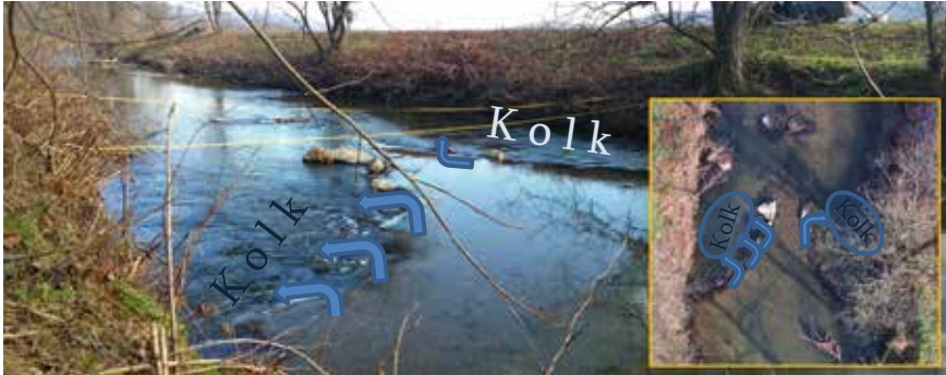
Abb. 5: Deklinante Trichterbuhne, Entnahmestrecke Sulm/Gleinstätten. Die Lenkung des Stromstrichs in Richtung Uferböschung setzt eine entsprechend stabile Uferböschung voraus © IB Parthl
