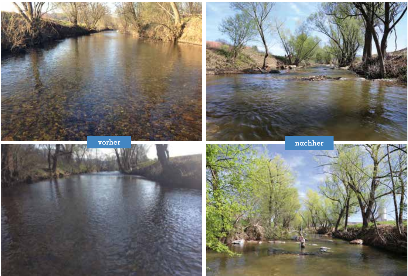
Abb. 29: Entnahmestrecke des E-Werks Gleinstätten vor (Foto links oben und links unten) und nach der Strukturierung mit Lenkbuhnen © IB Parthl
