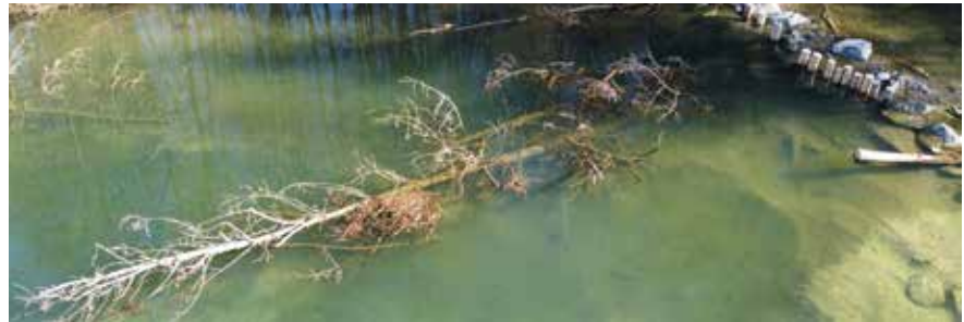
Abb. 20: Wurzelstockbuhne im Längsschnitt und im Detail © IB Parthl
