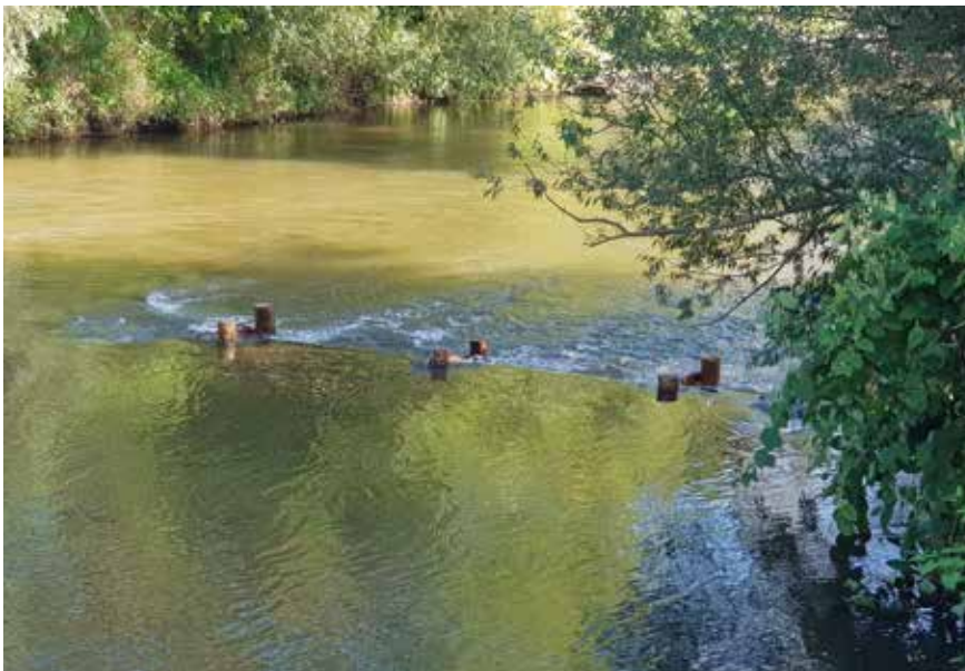
Abb. 18: Trichterbuhne in kombinierter Holz/Bruchstein/Holzpfählen-Bauweise, Sulm/Leibnitz © IB Parthl
