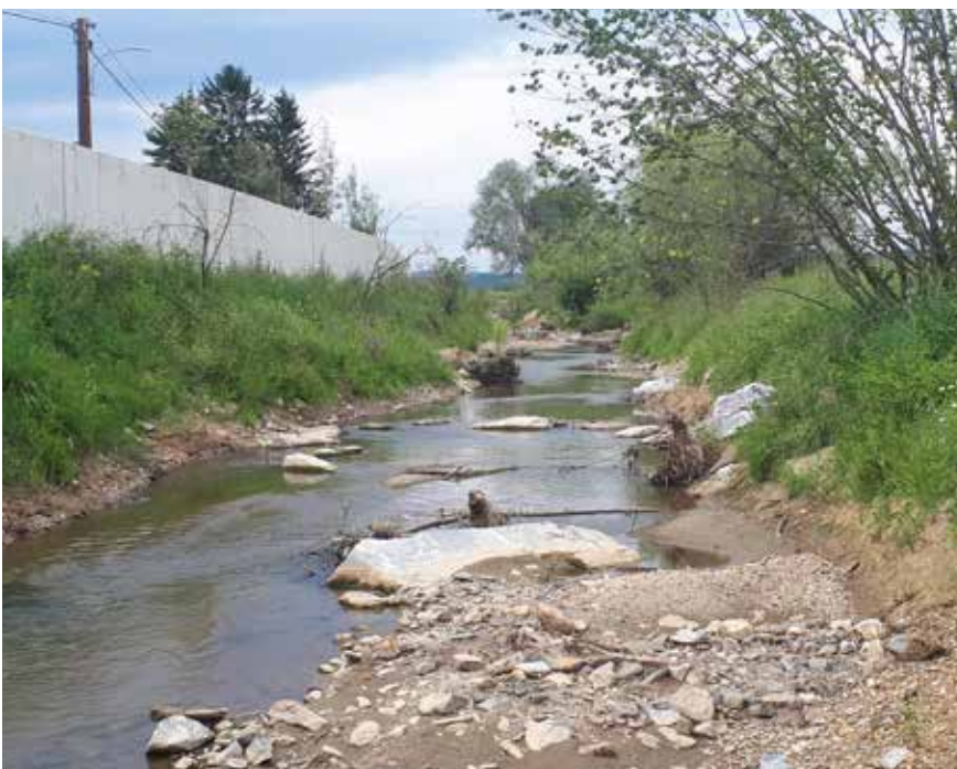
Abb. 4: Morphologische Aufwertung des Liebochbaches im Rahmen des Hochwasserschutzprojektes © A14/Ambrosch
