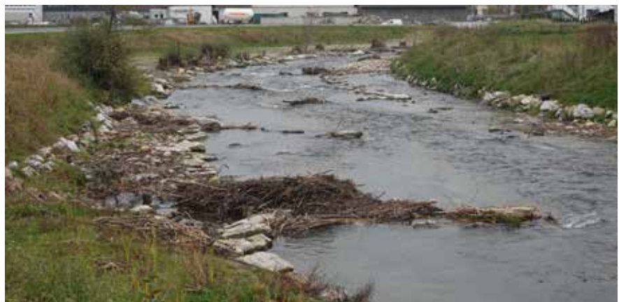
Abb. 10: Lafnitz bei Rohrbach: Leicht gegen die Fließrichtung ausgerichtete Stammhubne aus gebündeltem Kleingehölz in Kombination mit Bruchsteinen, konzentriert den Niederwasserabfluss auf das Gleitufer und führt hier zu Erosion, während das Prallufer bei Hochwasser entlastet wird © IB Parthl
