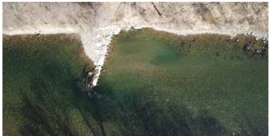
Abb. 15: Kombinierte Lenkbuhne mit Bruchsteinen und Lärchenpiloten zur unterwasserseitigen Buhnensicherung, Mur, Flusskilometer 335,5 und 339,1 zwischen St. Peter und St. Georgen ob Judenburg © links IB Parthl, rechts Drohnfoto DI Karl Sackl
