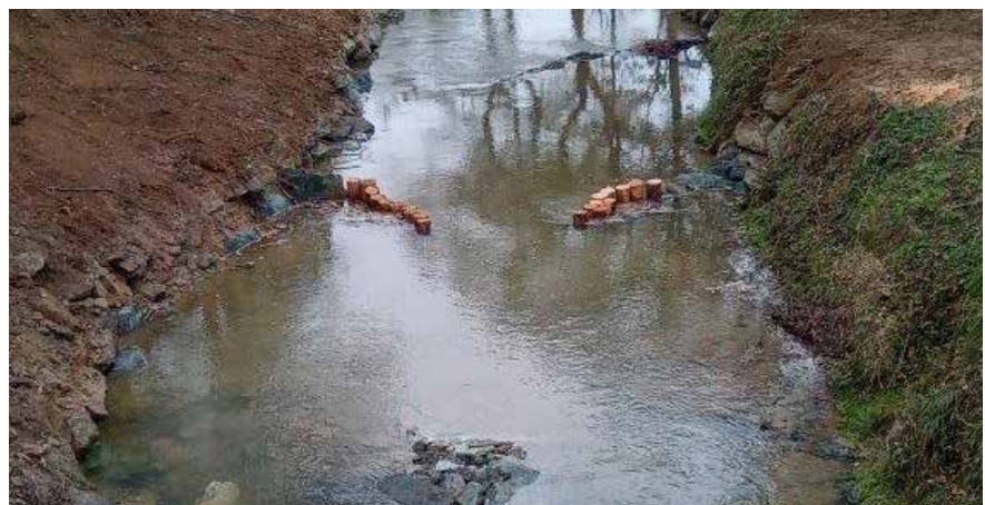
Abb. 21: Raubäume zur Strukturierung der Uferböschungen, Sulm/Gleinstätten © IB Parthl
