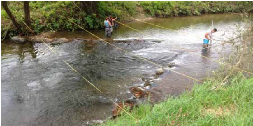
Abb. 6: Inklinante Trichterbuhne, Entnahmestrecke Sulm/Gleinstätten. Durch die Lenkung des Stromstrichs in Richtung Gewässermittle kommt es zu einer Entlastung der Uferböschungen im Hochwasserfall © IB Parthl
