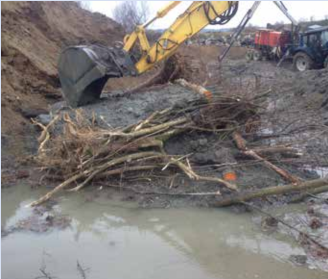
Abb. 30: Maschinelles Einlegen von Biotopholz und ausschlagfähigen Gehölzen (Raab Hohenbrugg/Welten) © IB Parthl
