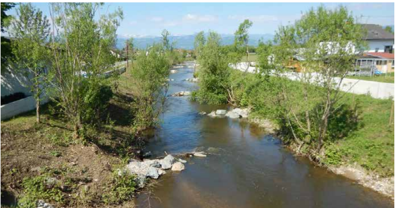
Abb. 5: HWS-Maßnahmen in Grünau/Groß St. Florian – Verbesserung der Ufer- und Sohlstruktur © A14/Ambrosch
