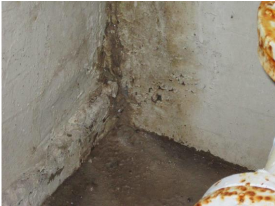
Undichtheiten Schieberkammer
