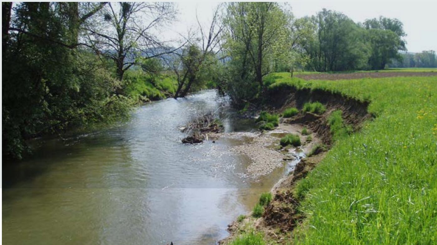
Abb. 13: Nicht korrigierter Ufereinriss als erstes Stadium einer Dynamisierung © A14
