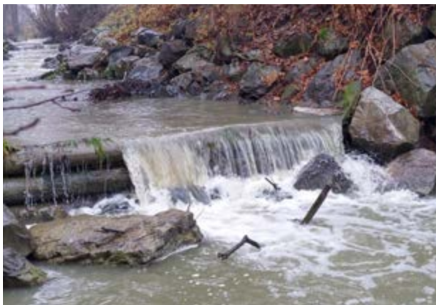
Abb. 3 und 4: Für typische Fische des Raabtales unpassierbare Querbauwerke © A14
