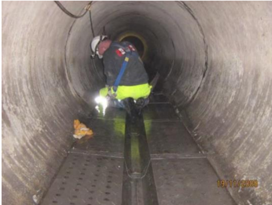
Abb. 4: Direkte Einbauten im Kanal
