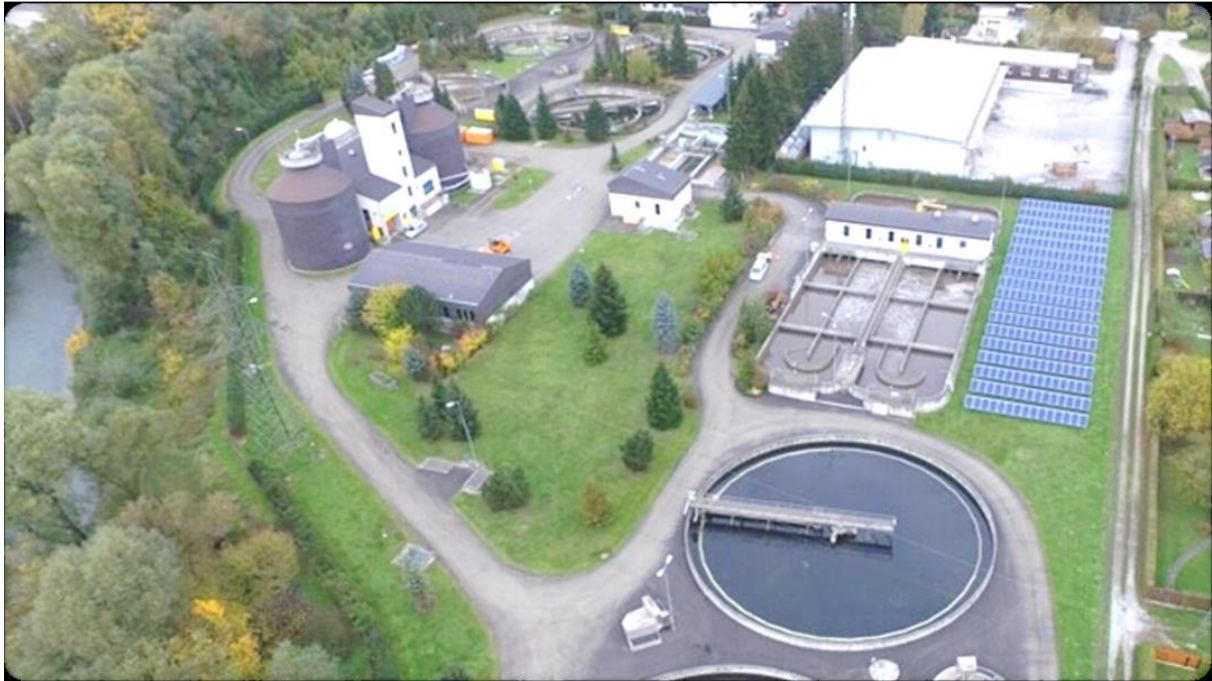
Abb. 10: Kläranlage Kapfenberg Mürz IV (Bildquelle: WV Mürzverband, 2020)
