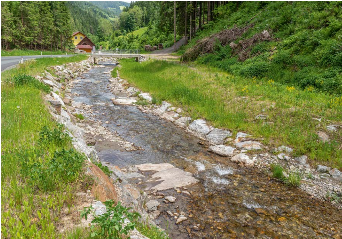
Lineare Regulierung eines Gewässers als aktive Hochwasserschutzmaßnahme (Beispiel Gasenbach 2021) © A14
