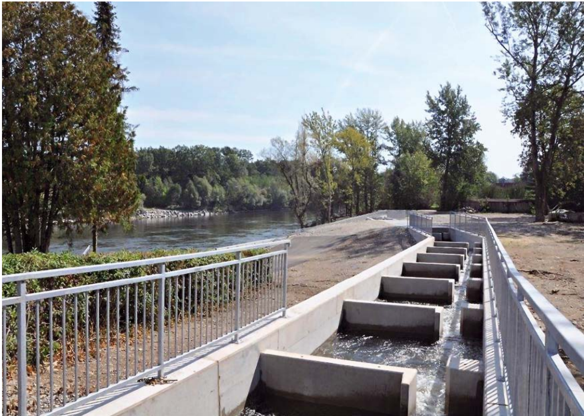
Fischaufstiegshilfen sind wesentliche Maßnahmen zur Sanierung der Fließgewässer © IB Parthl
