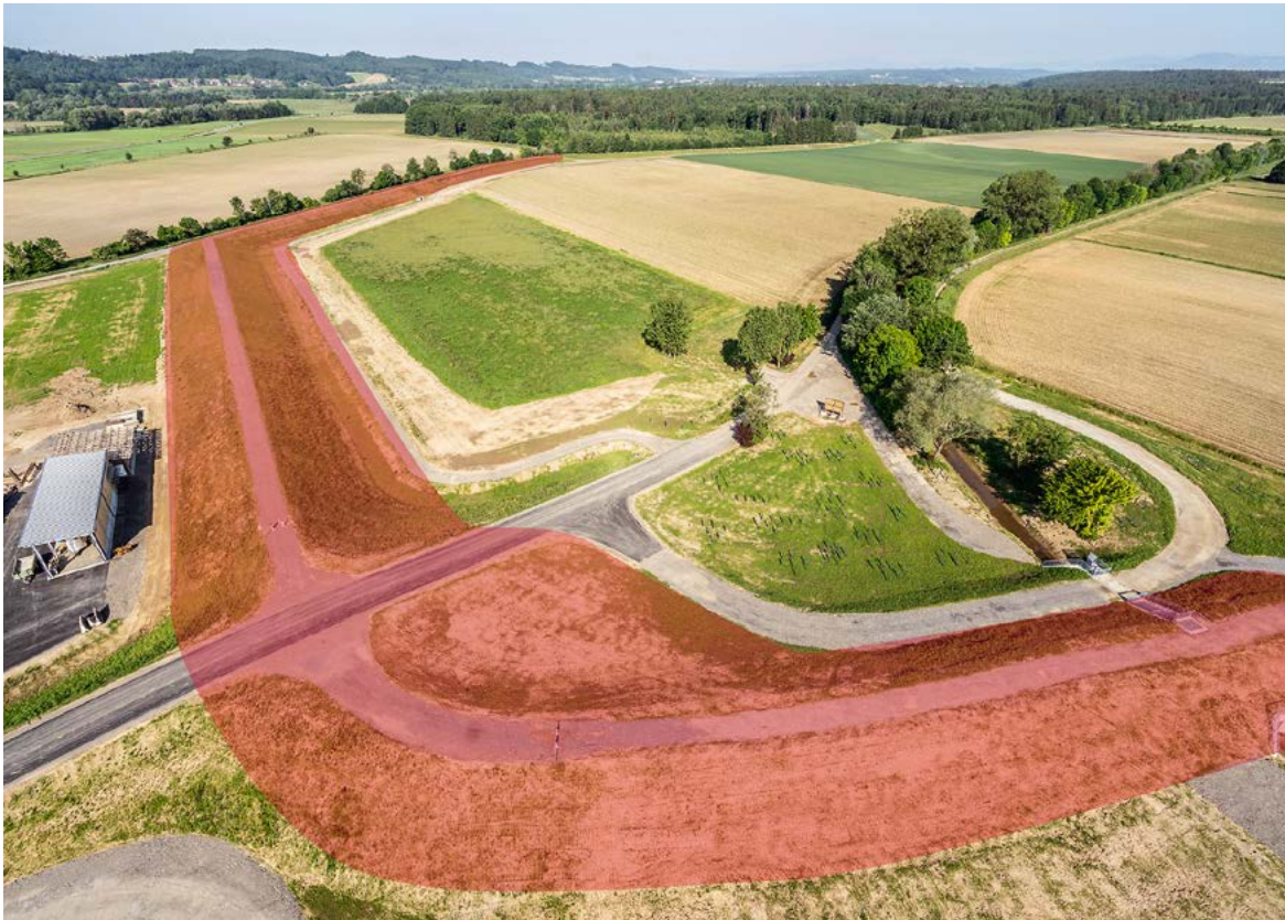
Der Ausbau von Rückhaltebecken gilt seit vielen Jahren als wichtige Strategie für effektiven Hochwasserschutz (Beispiel RHB Altenmarkt Fürstenfeld) © A14
