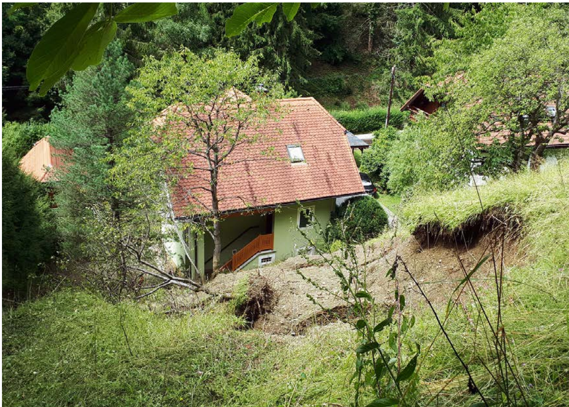
Rutschung gefährdet Wohnobjekt (Beispiel Mariatrost 2021) © A14
