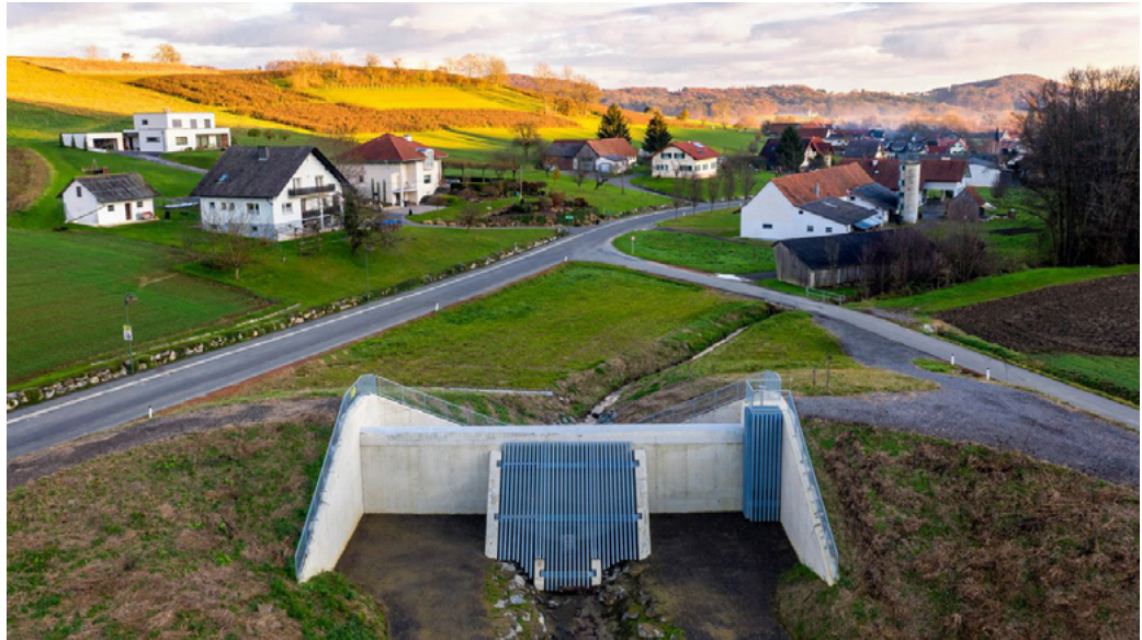
Rückhaltebecken Raning in der Marktgemeinde Gnas
