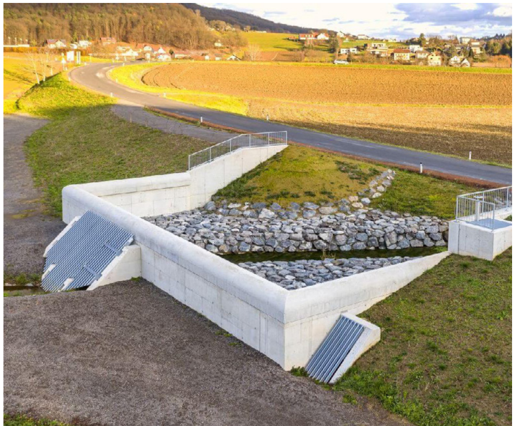
Rückhaltebecken Raning in der Marktgemeinde Gnas
