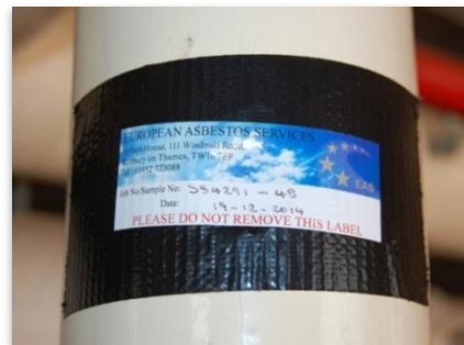
Rohr mit Hinweismarkierung für Asbest, Quelle: UEPG
