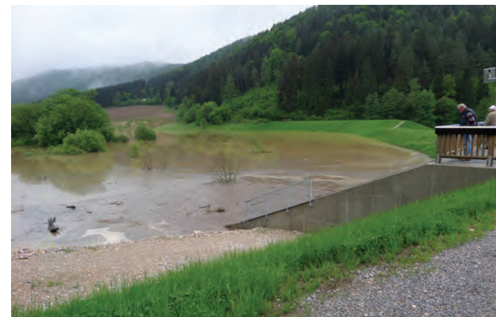
Hochwasser Mai 2013, RHB Schöckelbach, Weinitzen
