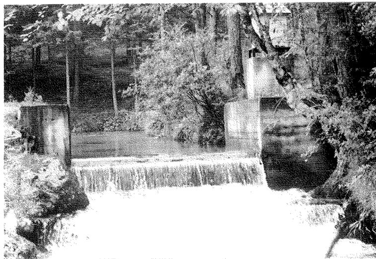
Abb. 3: Meßüberfall in Beton und Stahl
