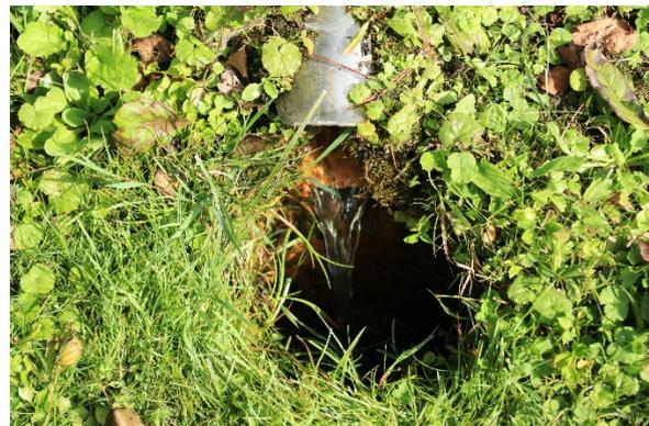
*Abbildung 3: Schachtfassung des Säuerlings von Klapping mit freiem Überlauf (Fotos: M. Ferstl)*
