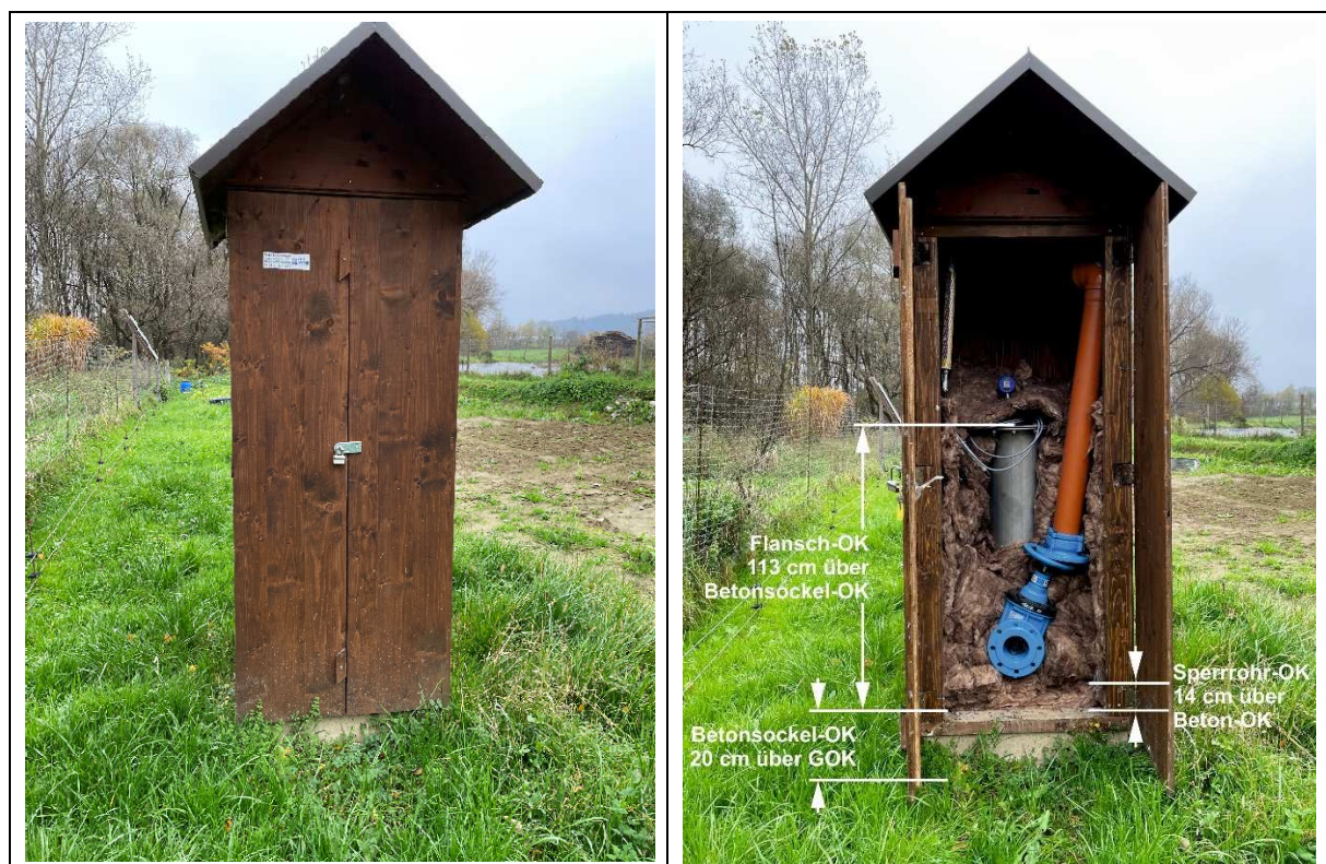
Abbildung 4.1: TGWM Zöbing – Messhütte und Pegelabschluss (Status 16.11.2022).
