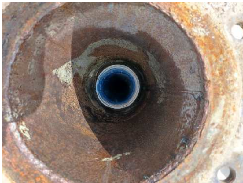
Abbildung 5.31: TGWM Schachendorf – Probenahme. links: Sondenkopf (provisorisch). rechts: Blick in die Pegel-Verrohrung.
