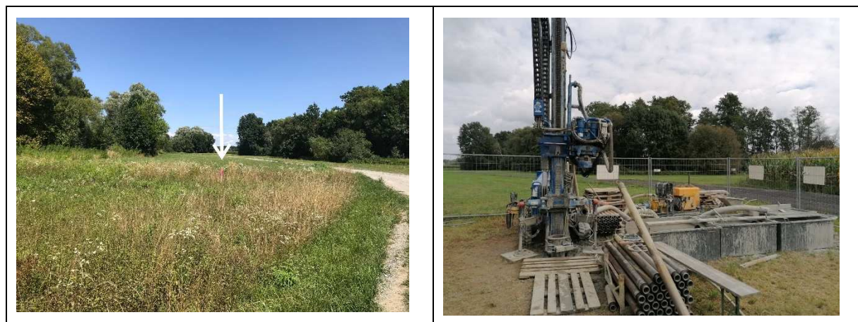
Abbildung 5.3: TGWM Deutsch Kaltenbrunn - links: Ansatzpunkt. rechts: Bohrstelle.
