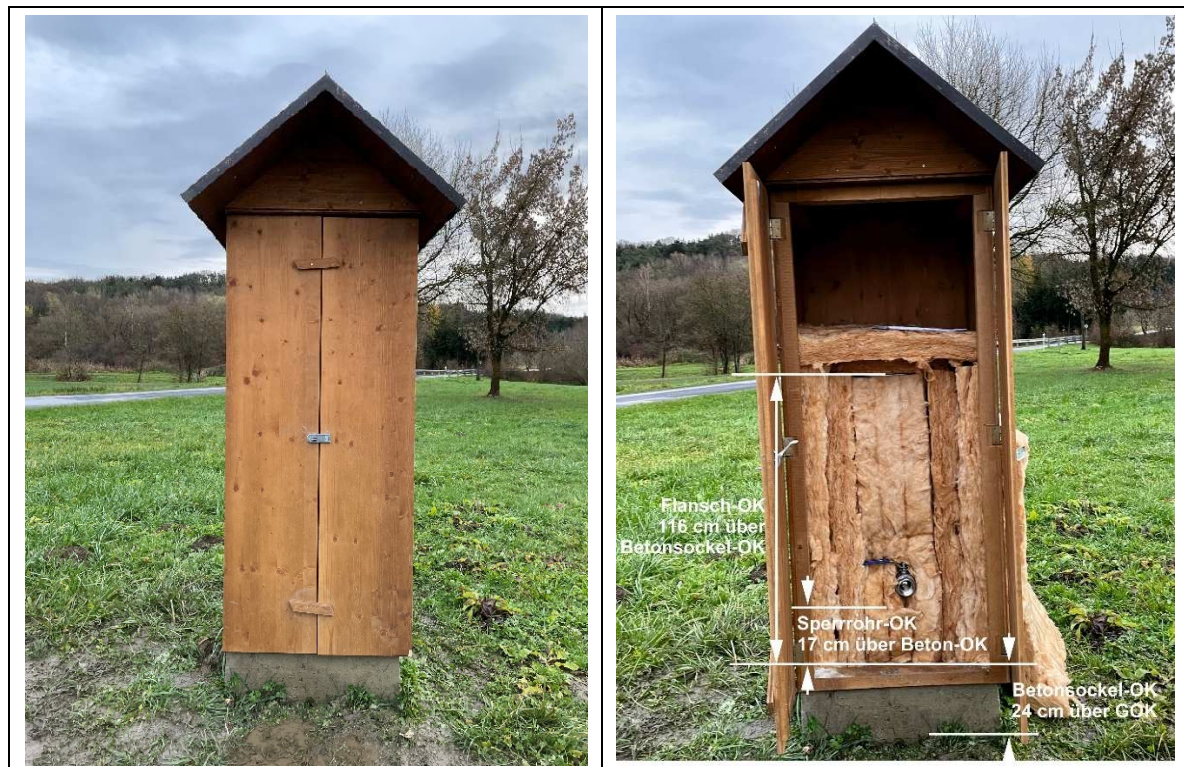
Abbildung 5.32: TGWM Rauchwart – Messhütte und Pegelabschluss (23.11.2022).
