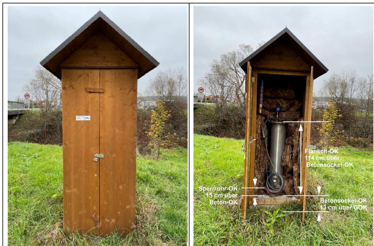
Abbildung 4.8: TGWM Untergroßbau – Messhütte und Pegelabschluss (16.11.2022).
