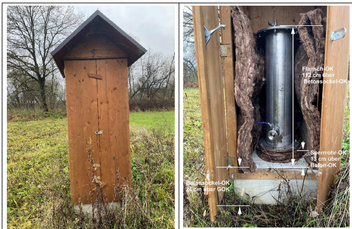
Abbildung 5.1: TGWM Deutsch Kaltenbrunn – Messhütte und Pegelabschluss (23.11.2022).
