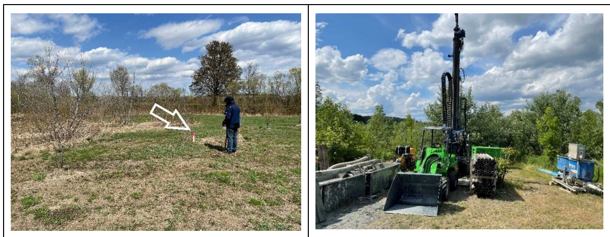
Abbildung 5.19: TGWM Auboden - links: Ansatzpunkt. rechts: Bohrstelle.
