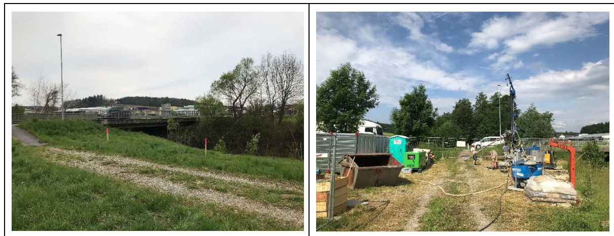
Abbildung 4.10: TGWM Untergroßbau - links: Ansatzpunkt, rechts: Bohrstelle.
