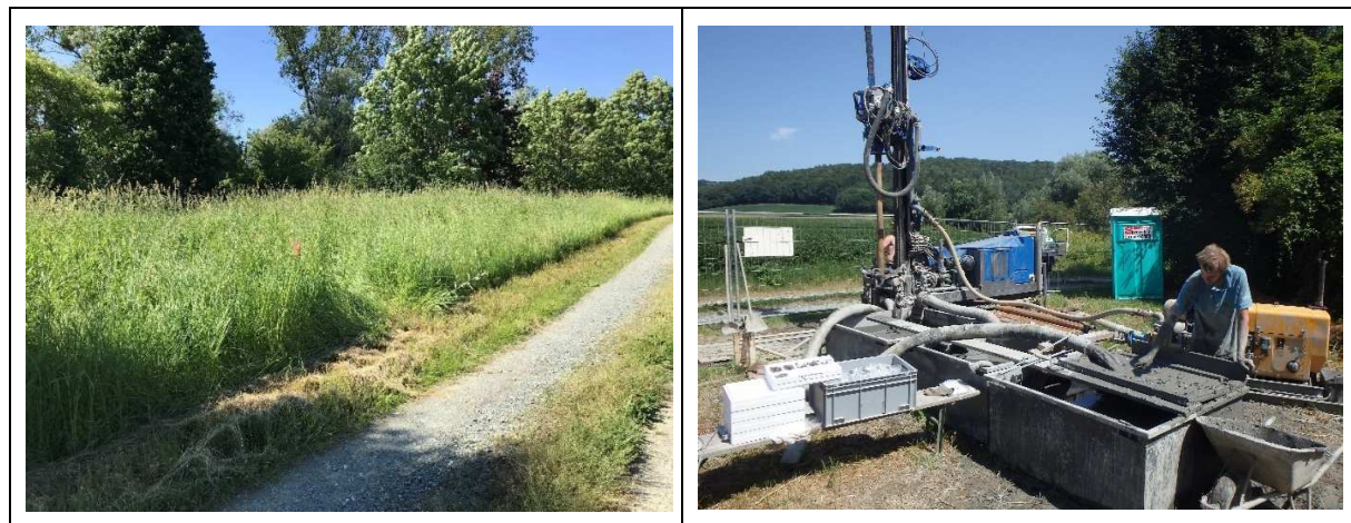
Abbildung 4.30: TGWM Hohenbrugg - links: Ansatzpunkt. rechts: Bohrstelle.
