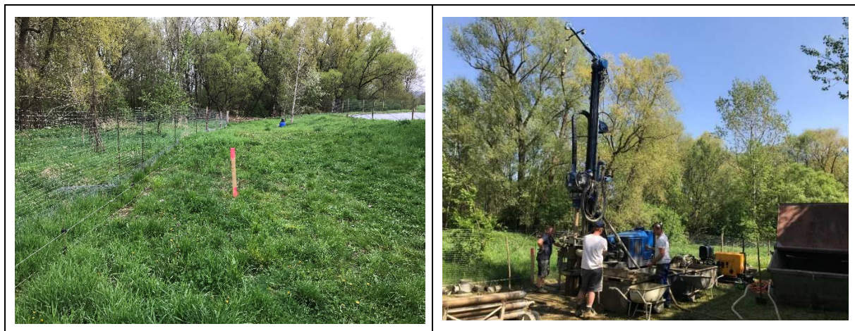
Abbildung 4.3: TGWM Zöbing – Auspflockung Bohrpunkt (links) und Bohrstelle (rechts).
