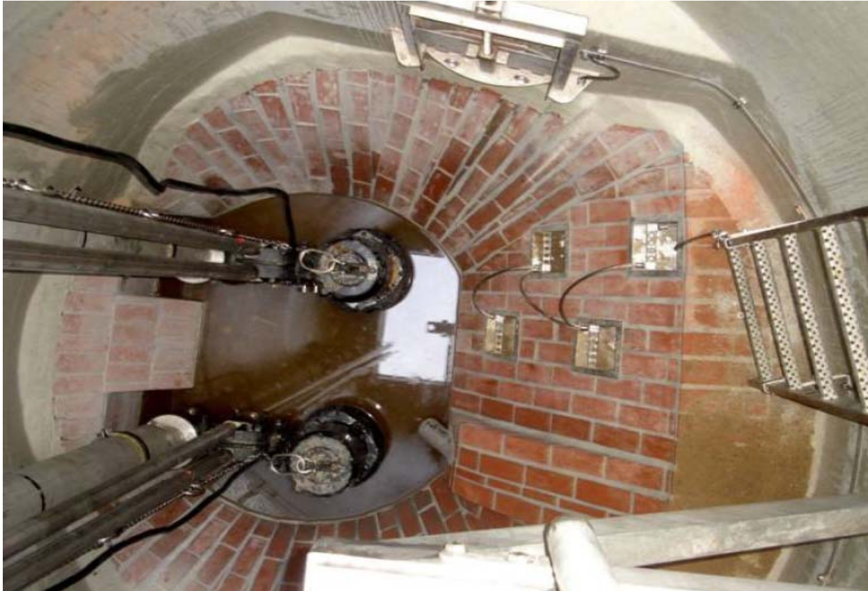
Abbildung 12 – Pumpensumpf nach Adaptierung (TORNOW, 2010)
