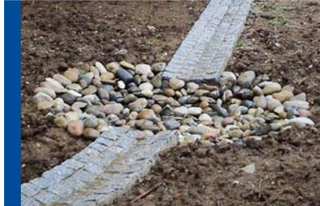
Beispiel für eine Versickerungsanlage
