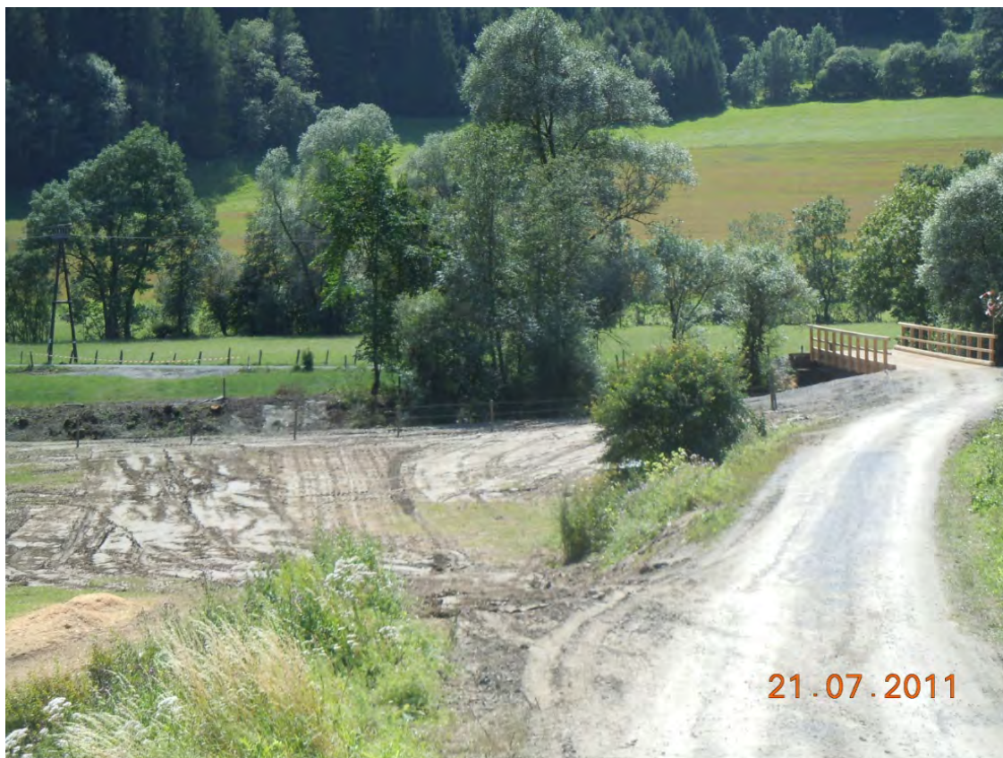
Abbildung 27: vom Bundesheer neu errichtete Brücke am Wözerbach (Foto FA19B HWS Wölzertal_Winklern 697)
