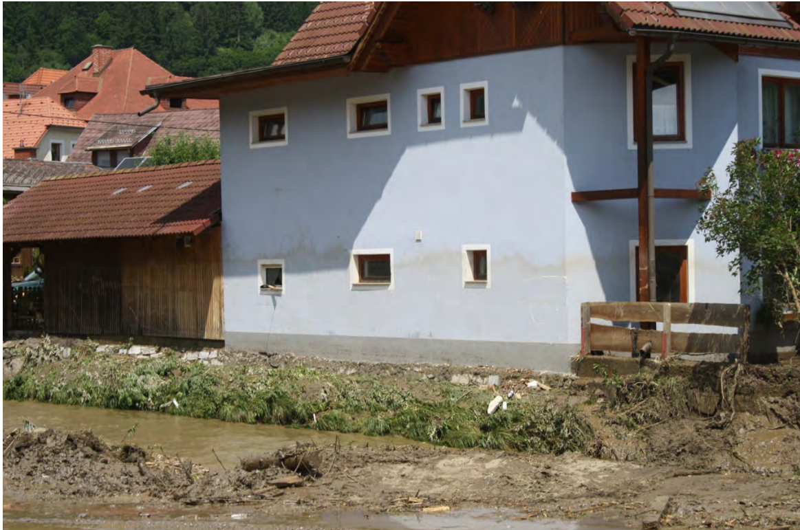
Abbildung 25: bachnahes Gebäude in Niederwölz, knapp bachauf der Straßenbrücke (Foto Diebold_6935)
