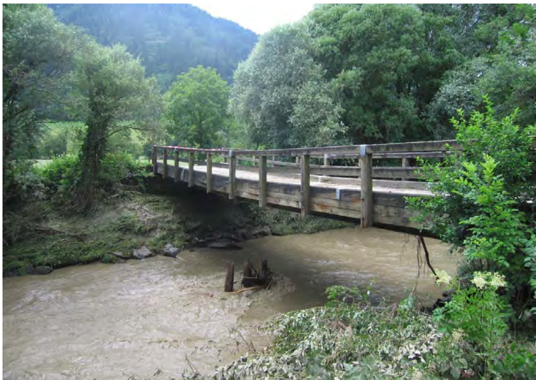
Abbildung 16: Brücke bei km 7.6; Querstraße Richtung Salcher; (Foto Hydroconsult HW_076)
