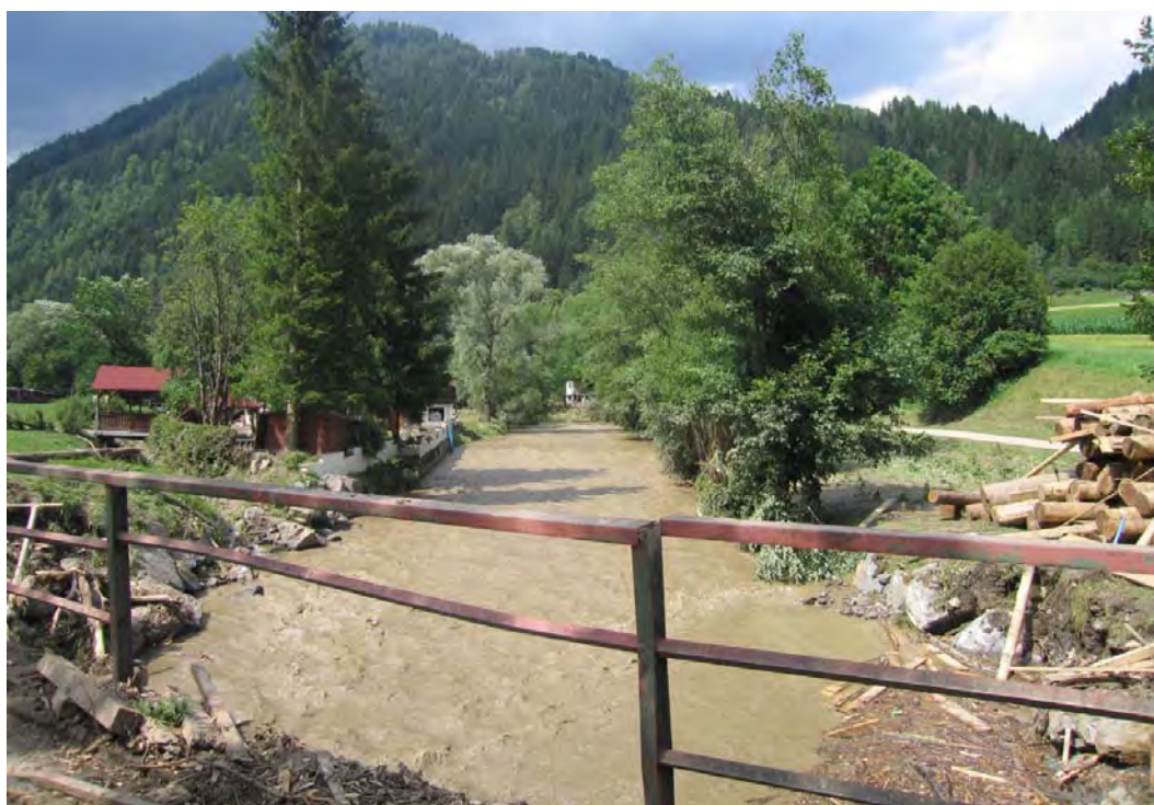
Abbildung 20: Brücke zum Schloss Pachern; Blick gegen die Fließrichtung (Foto Hydroconsult HW_111)
