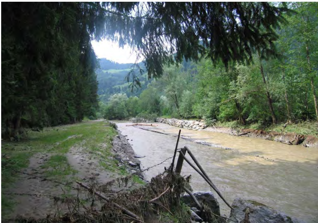
Abbildung 21: Blick von der Wehranlage gegen die Fließrichtung (Foto Hydroconsult HW_111)
