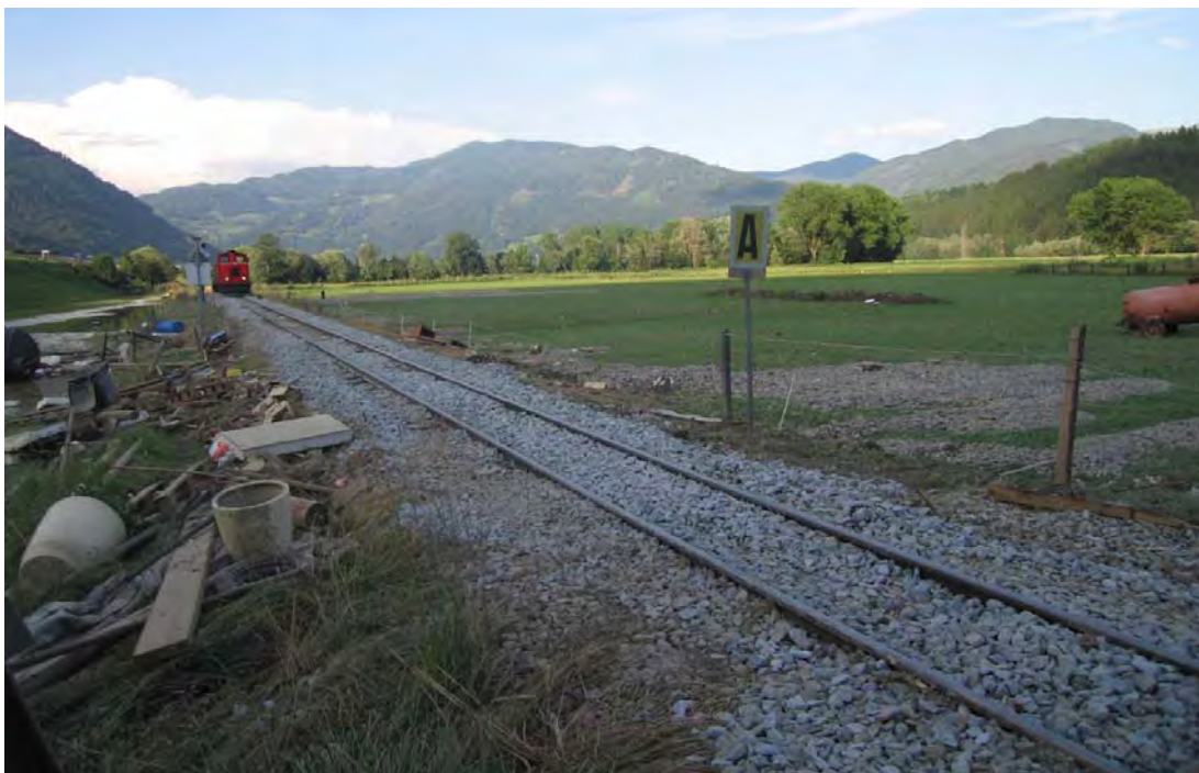
Abbildung 31: Bahnstrecke in Niederwölz; Überströmung beim Hochwasser (Foto Hydroconsult_HW_228)
