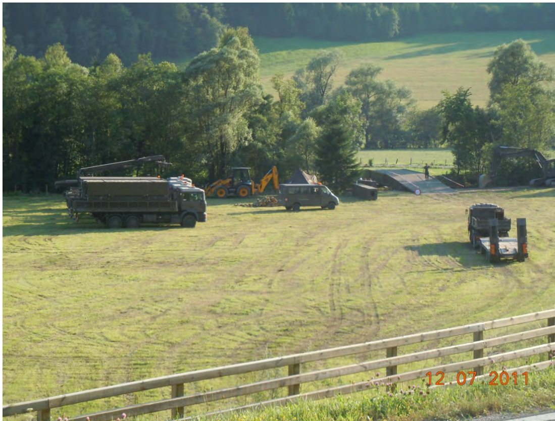
Abbildung 28: vom Bundesheer neu errichtete Brücke am Wözerbach (Foto FA19B HWS Wölzertal_Winklern 147
