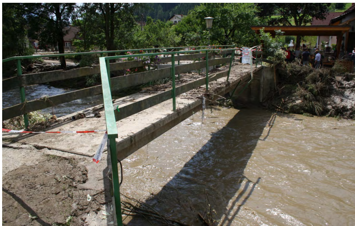
Abbildung 23: Steg in Niederwölz (Foto Diebold_7010)
