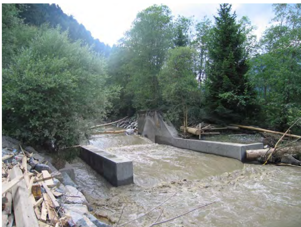
Abbildung 53: Wehranlage Schmid nördlich von Hinterbichl; Blick gegen Fließrichtung; (Foto Hydroconsult HW_132)
