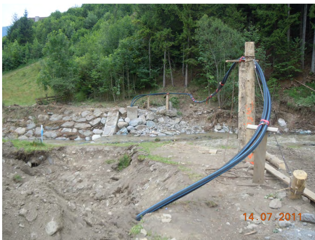
Abbildung 30: provisorische Trinkwasserversorgung (Hochdruckleitung Oberwölz) (Foto FA19B HWS Wölzerbach_Winklern 206)
