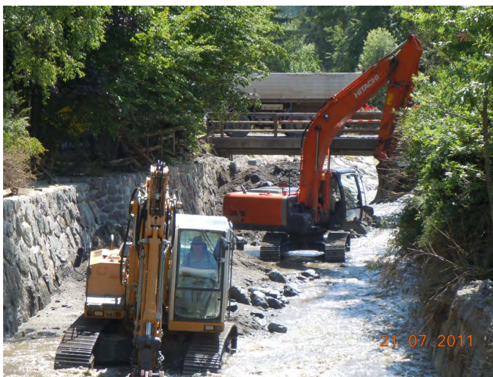
Abbildung 41: Schöttlbach in Oberwölz; Ausbaggerungen zur Wiederherstellung des Bachbettes des Schöttelbaches (FA19B HWS_Wölzerbach_Winklern_245)
