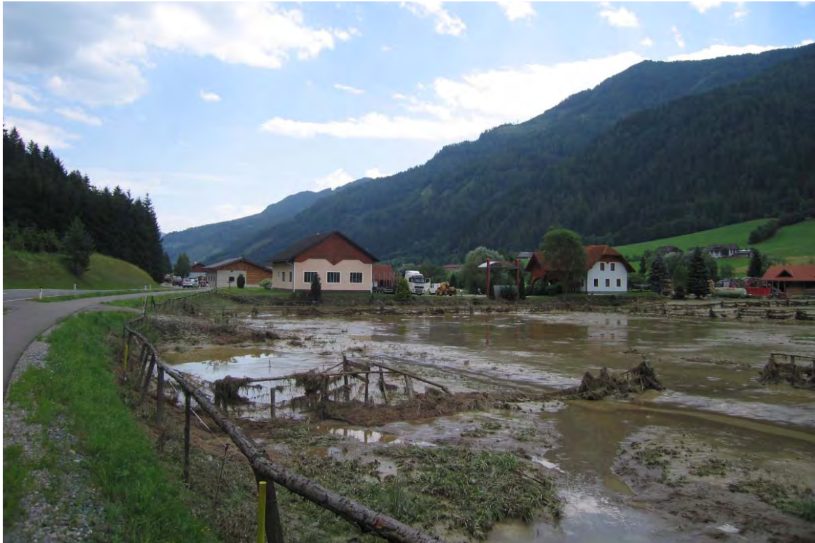
Abbildung 14: Blick Richtung Süden; Häuser in Raiming zwischen Bundesstraße und Wölzerbach; (Foto Hydroconsult HW_052)
