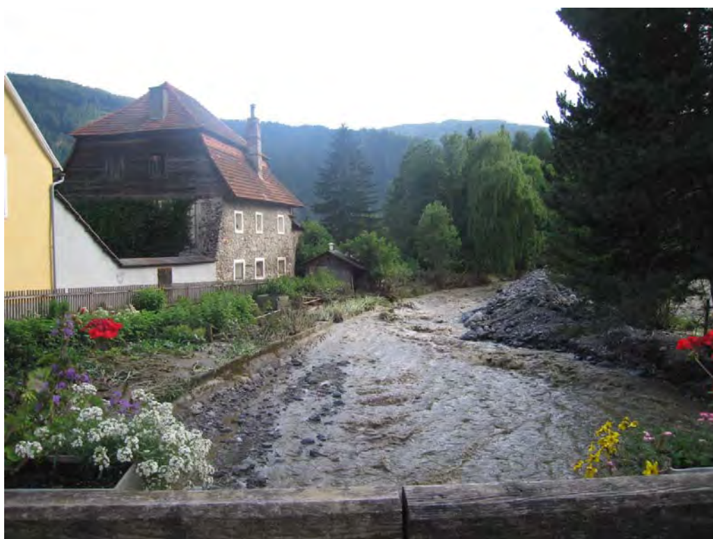
Abbildung 43: Schöttlbach in Oberwölz; Blick in Fließrichtung; Verlandung des Bachbettes (Foto Hydroconsult HW_0178)
