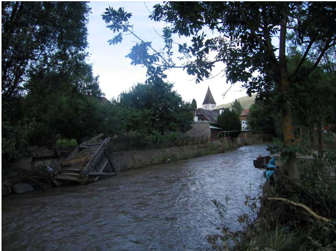
Abbildung 22: ehemaliger Steg in Niederwölz; Nähe Skaterplatz (Foto Hydroconsult HW_235)
