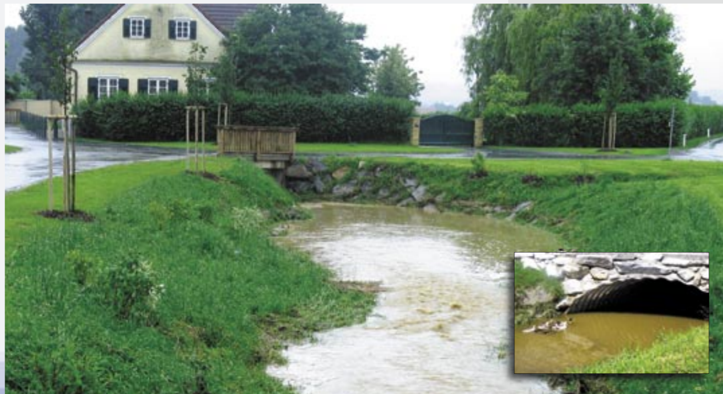
Hochwasser vom 18. Juni 2008 - schadensfreie Abfuhr der retentierten Wassermengen
