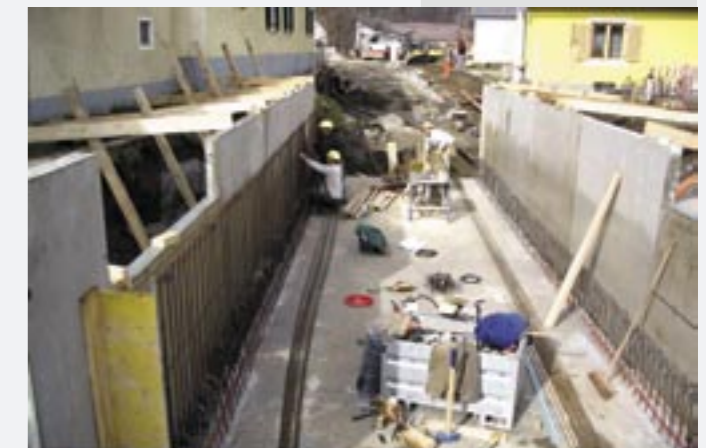
Überbauung „Wisiak“ in der Bauphase, beengte Platzverhältnisse
