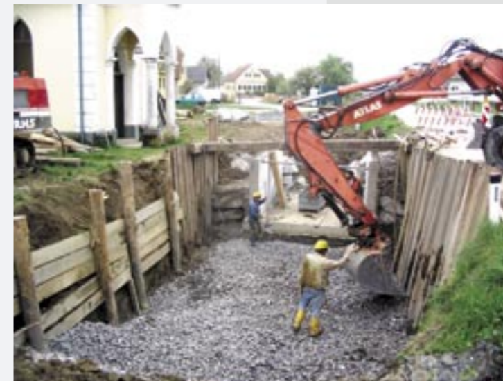
Linearmaßnahmen in der Bauphase
