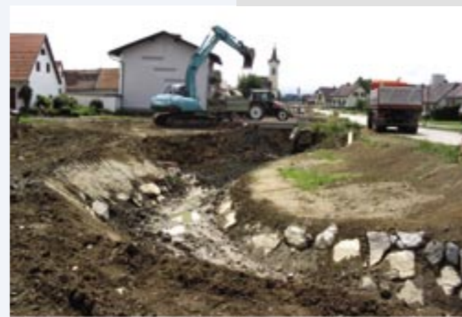
Bachaufweitungen im Dorfanger in der Bauphase, nach Fertigstellung und Hochwasser vom 18. Juni 2008
