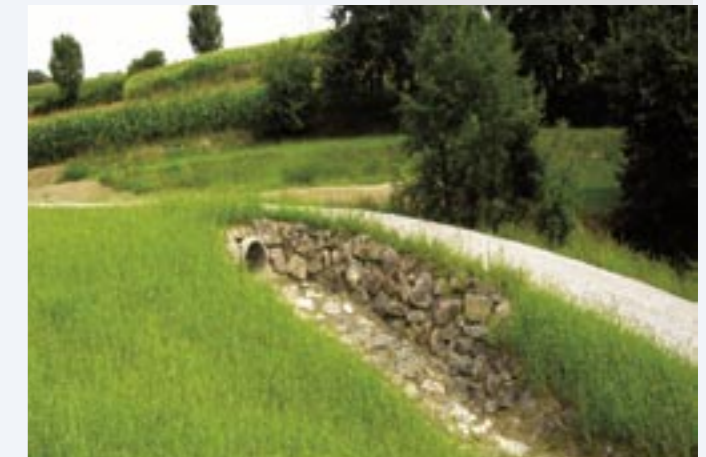
Eingestauter Rückhaltebeckenstauraum, 18. Juni 2008
