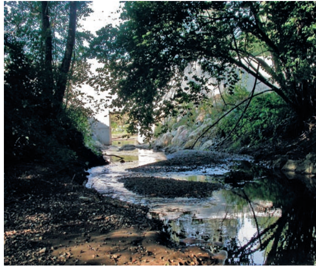
Ungesteuerter Grundablass durch die Sperrenmauer.
