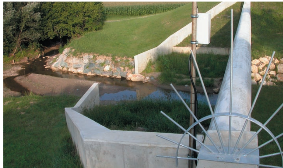
Ist das Rückhaltebecken voll, fließt das Wasser über die Sperrenmauer.
