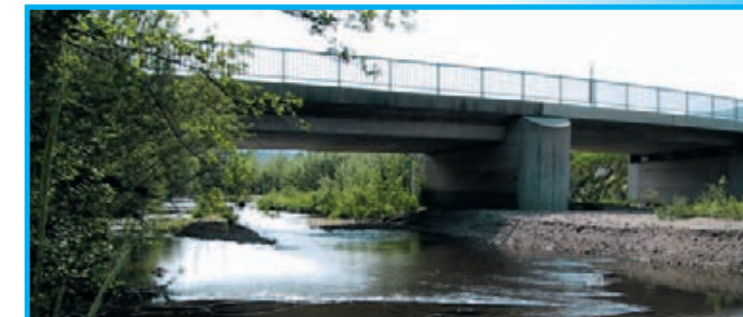
Die durch ein zusätzliches Brückenfeld von 12,5 Metern aufgeweitete Saggaubrücke.
