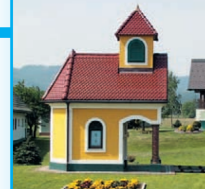
Die kleine Kapelle musste im Zuge der Umbauarbeiten weichen und wurde in Eigenregie wieder neu aufgebaut.
