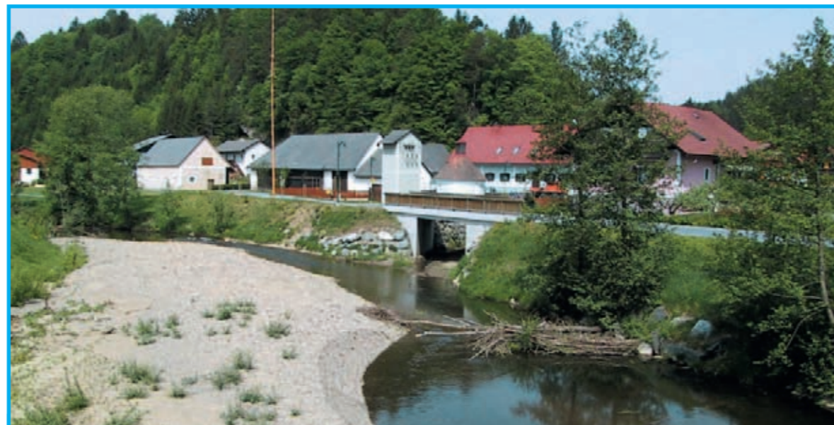
Das Bild zeigt die Situation flussaufwärts der Saggaubrücke. Die Objekte und der neu gestaltete Dorfplatz werden durch die in den Hochwasserschutzdamm integrierte Straße geschützt. Der hydraulisch optimierte Wuggaugrabenbach fließt jetzt sohlgleich durch die neu errichtete Brücke in die Saggau. Zur Strukturverbesserung wurde u. a. in der Saggau eine Baumbühne (rechts im Bild) errichtet, die gemeinsam mit Schwemmholz und der neu entstandenen Schotterbank von der Tierwelt gerne als neuer Lebensraum angenommen wird.
