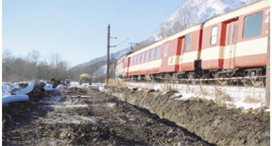
**HW-Schutz Enns bei Trautenfels. Hochwasserschutzdamm entlang der ÖBB in Bau.**
