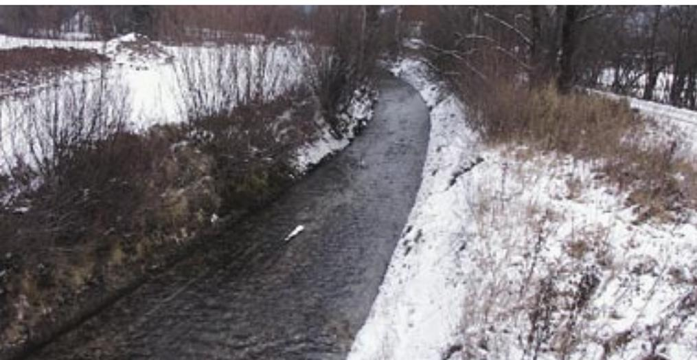
**Die Grimming vor den Baumaßnahmen, gestreckter Lauf, innerhalb von Beton-Talous (völlig glatte, 1:1 geneigte betonierte Böschungen) mit Holzbohlensohle.**
