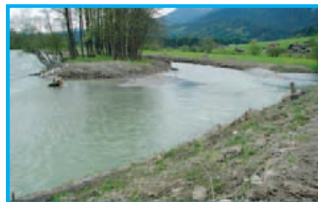
Flussaufwärts wurde hinter der ehemaligen Uferlinie ein Nebenarm mit dazwischen liegender Insel geschaffen. Die „Alte Lahn“ (rechts im Bild) mündet in diesen Nebenarm.
