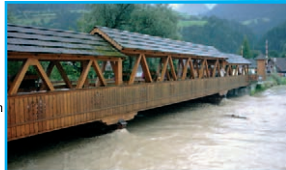
Nur ein halber Meter fehlte bis zur Aicher Brücke.
