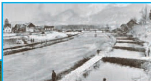
Bild aus dem Jahr 1907: Ufersicherungsmaßnahmen östlich der Aicher Brücke.
