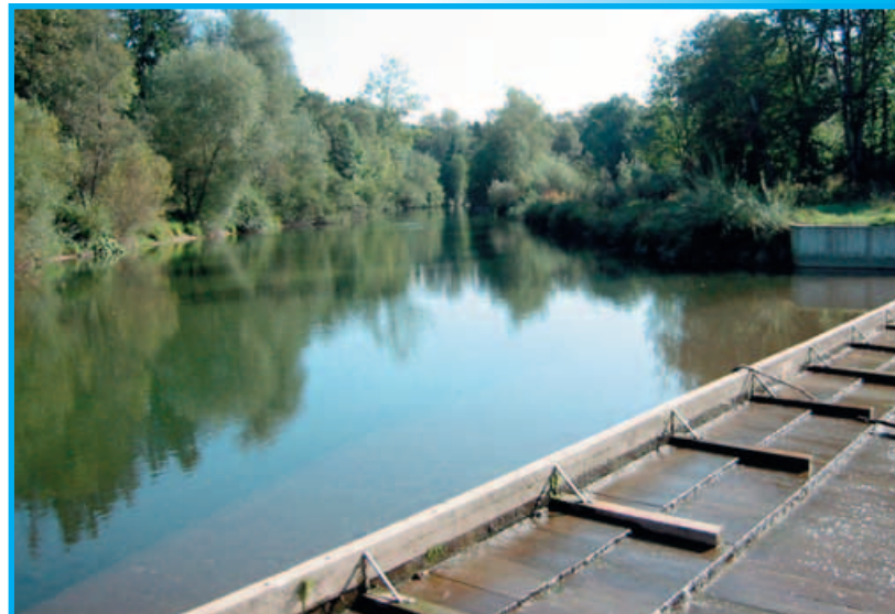
Wasserkraftanlage Feistritz – Wiedererrichtung in Holzbauweise
