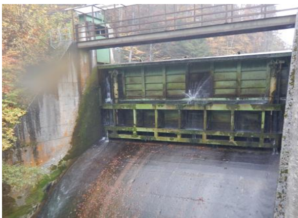
Abbildung 84: Wehranlage KW Krampen
