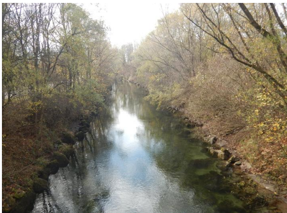
Abbildung 50: verbauter Abschnitt bei Fkm 33,6
