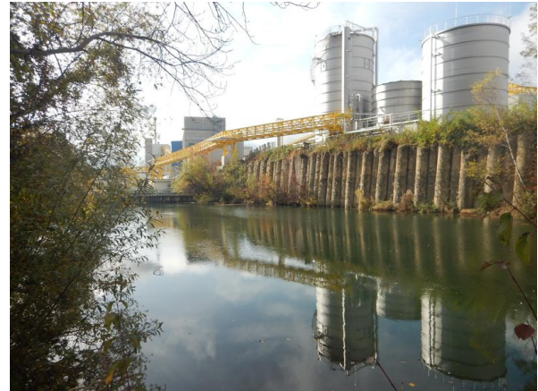
Abbildung 38: Stauraum KW Berndorf
