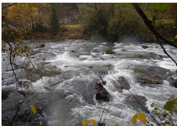
Abbildung 76: Sohlrampe bei ca. Fkm 56,0
