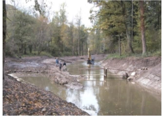
Verlängerung des Mureck-Radkersburger Mühlbaches zur Sicherung einer verbesserten Dotation
