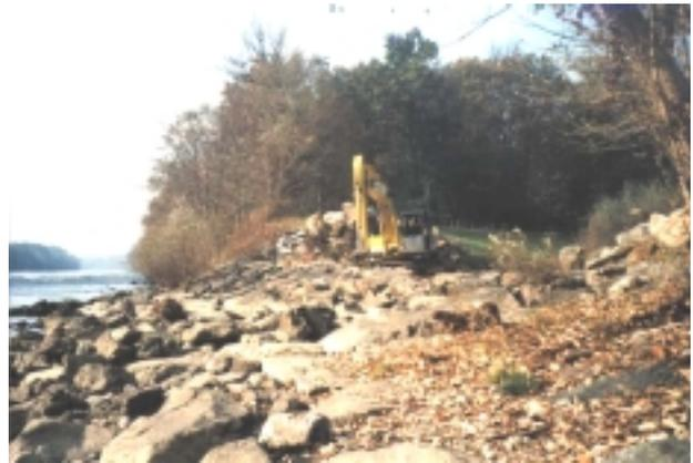
Umbau der Saßbachmündung – Entfernung der ca. 1m hohen Steinschlichtung
