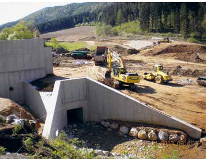
Abb. 3: Einschütten des Betonbauwerkes
