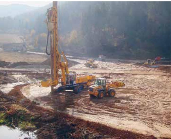
Abb. 2: Untergrundverbesserung mittels Rüttelstopfverdichtung
