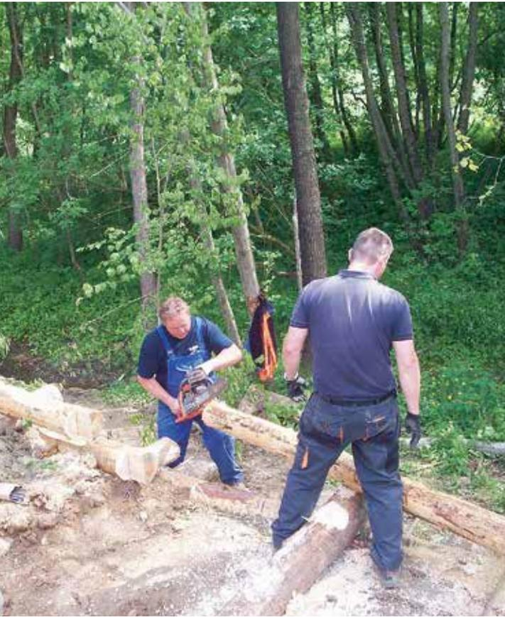
Abb. 5: Herstellung der Holzkrainerwand durch die Kollektivarbeiter der BBL
