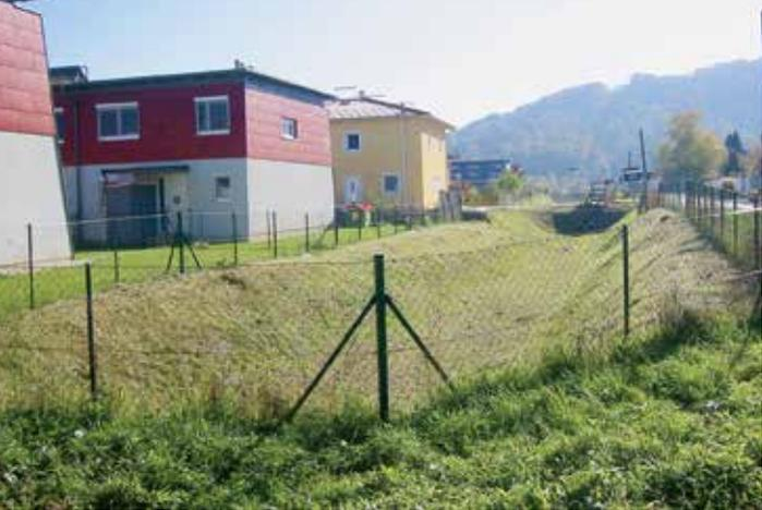
Abb. 2: Beispiel für ein Regenwasserversickerungsbecken
