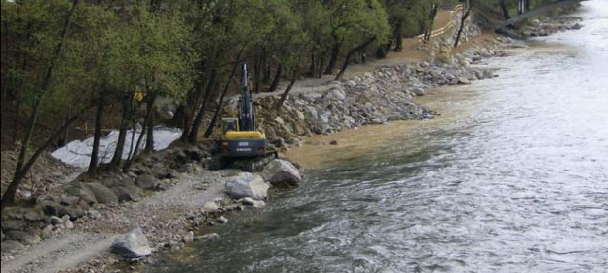
Abb. 2: Rückbau der Baustraße und Herstellen der Bühnen
