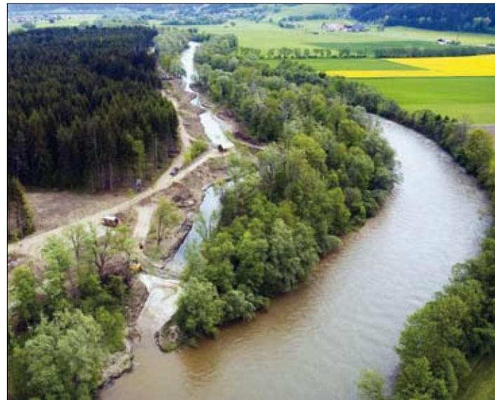
Altarmsanierung im Bereich Weyern
