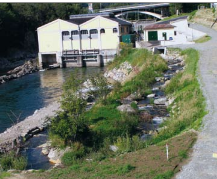
Fischwanderhilfe Kraftwerk Murau
