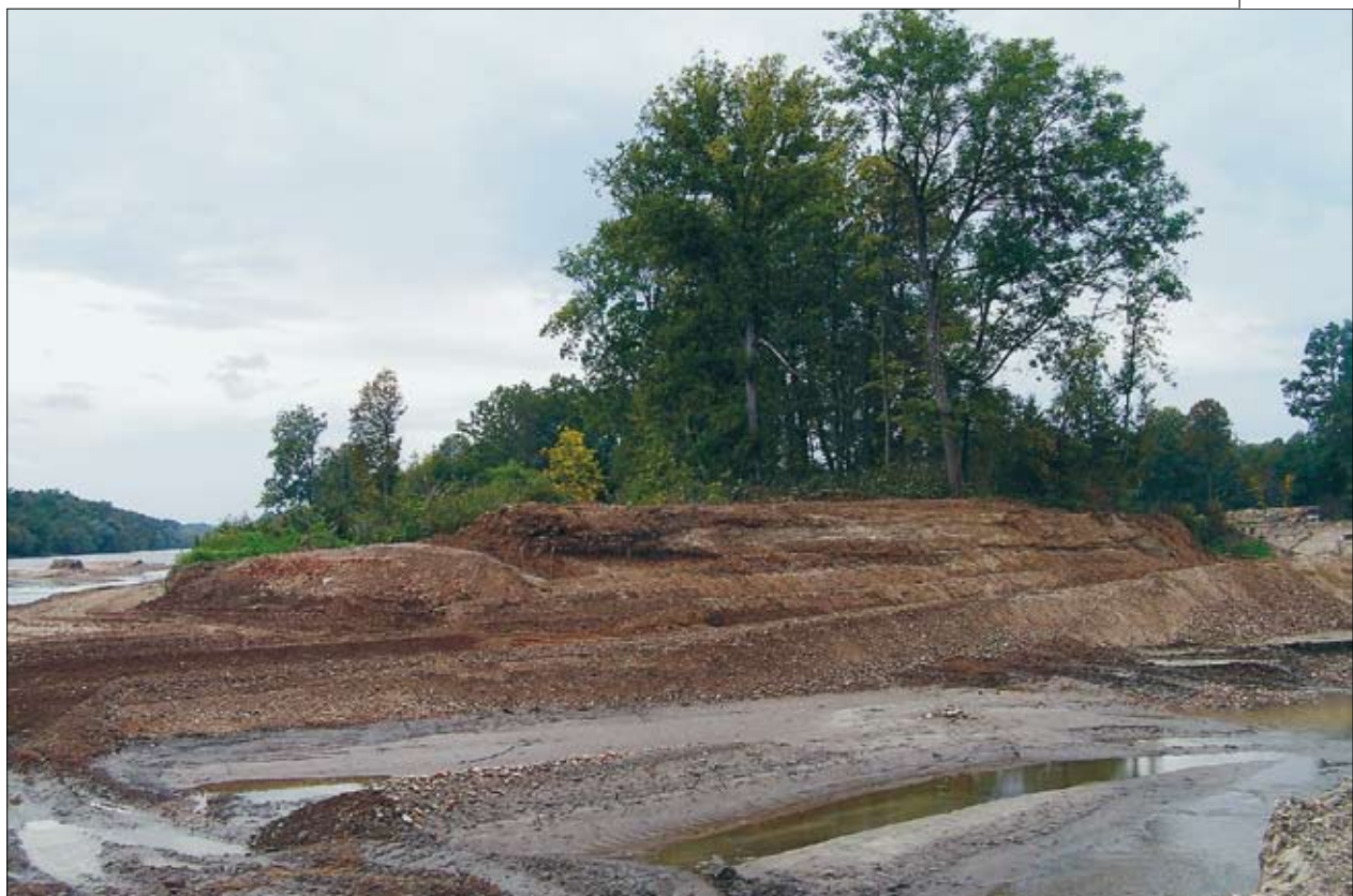
Abb. 1: Maßnahme an der Grenzmur: Aufweitung der Grenzmur in der Gemeinde Gosdorf (Umsetzung: BBL Feldbach)
