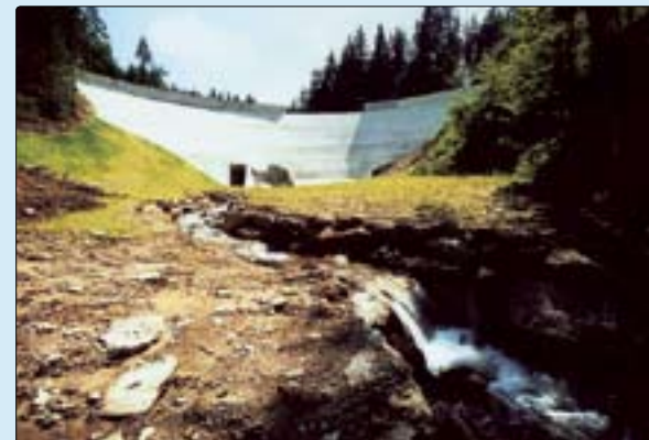
Rückhaltebecken (RHB) mit Betonmauer
