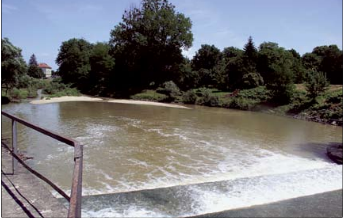
Abb. 2: Schaumbildung an der Raab - Sohlstufe bei St. Gotthard
