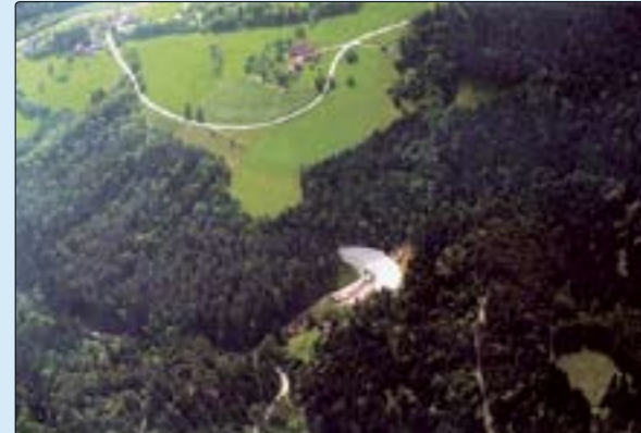
Rückhaltebecken Ligistbach: Ansicht „Luftseite“
