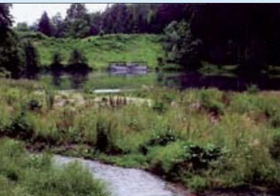
Rückhaltebecken Prätisbach mit Grundsee (seit 1986 in Betrieb!)
