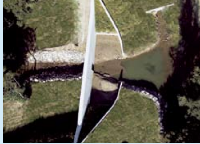
Sperrbauwerk am Gamlitzbach
