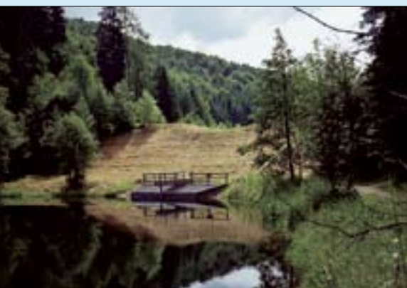
RHB Lafnitz-Waldbach: Erddamm mit Grundablass in der Fertigstellung
