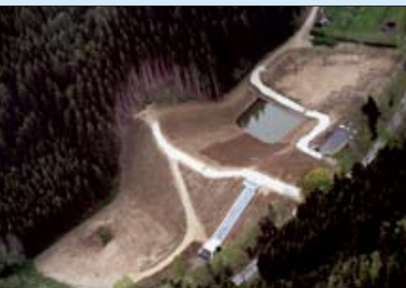
RHB Lafnitz-Waldbach: Erddamm mit Grundablass in der Fertigstellung
