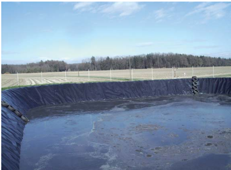
Güllelager als Jahresspeicher für sachgerechte, bedarfsorientierte Düngung
