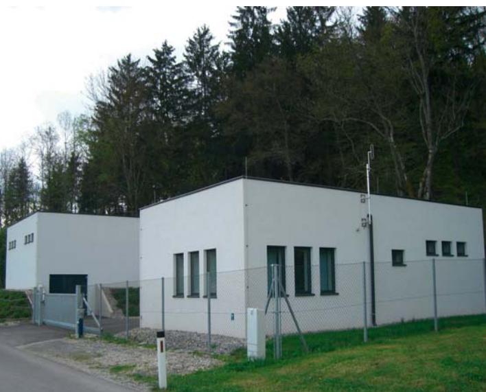
Zentralbrunnen Ludersdorf 1 (V. Winkler)
