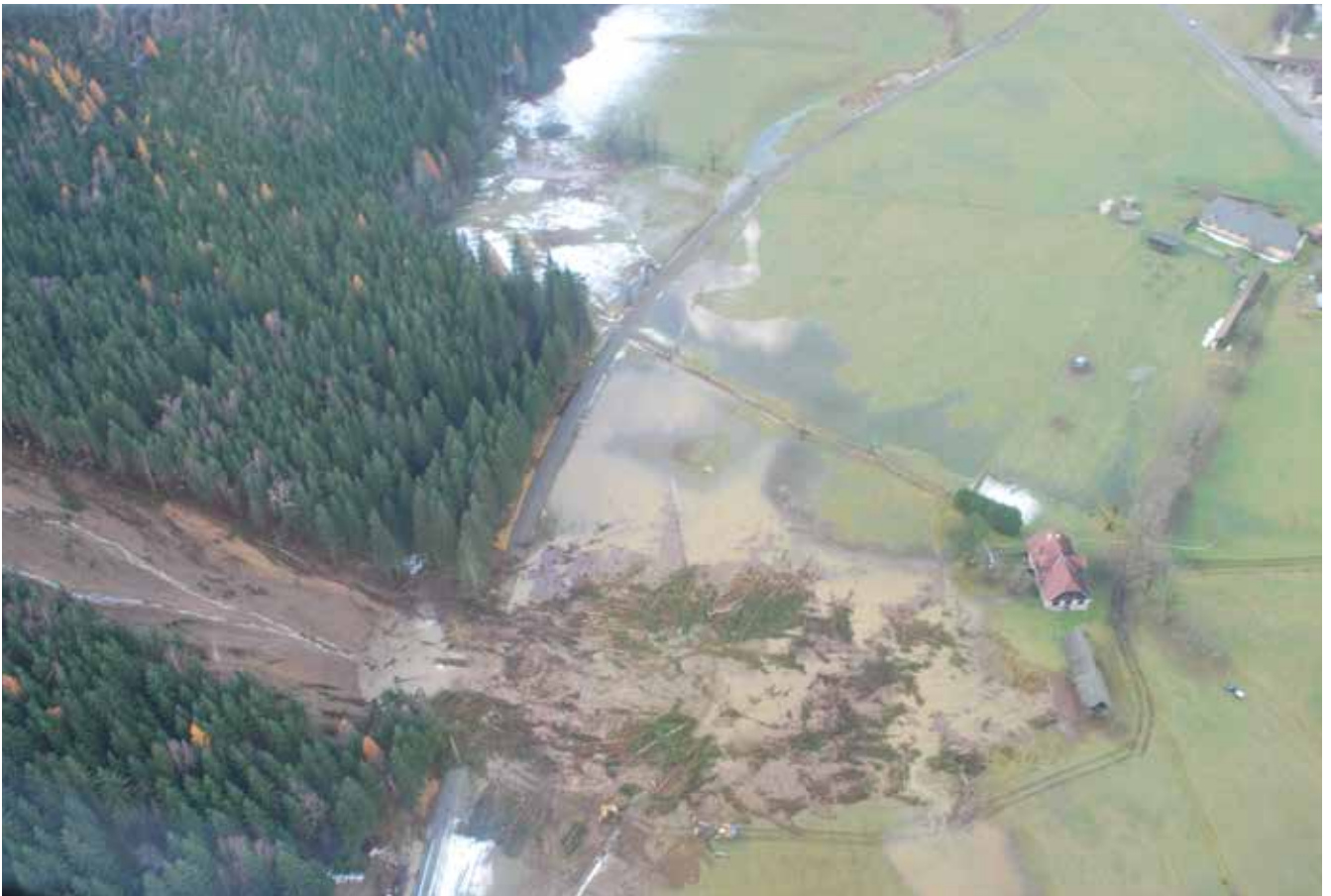
Abb. 11: Urlbach, Gemeinde Stadl-Predlitz, Zerstörung der Gleisanlagen der Murtalbahn und Verlegung des Hochwasserabflusses durch Ablagerungen einer Hangmure © WLV
