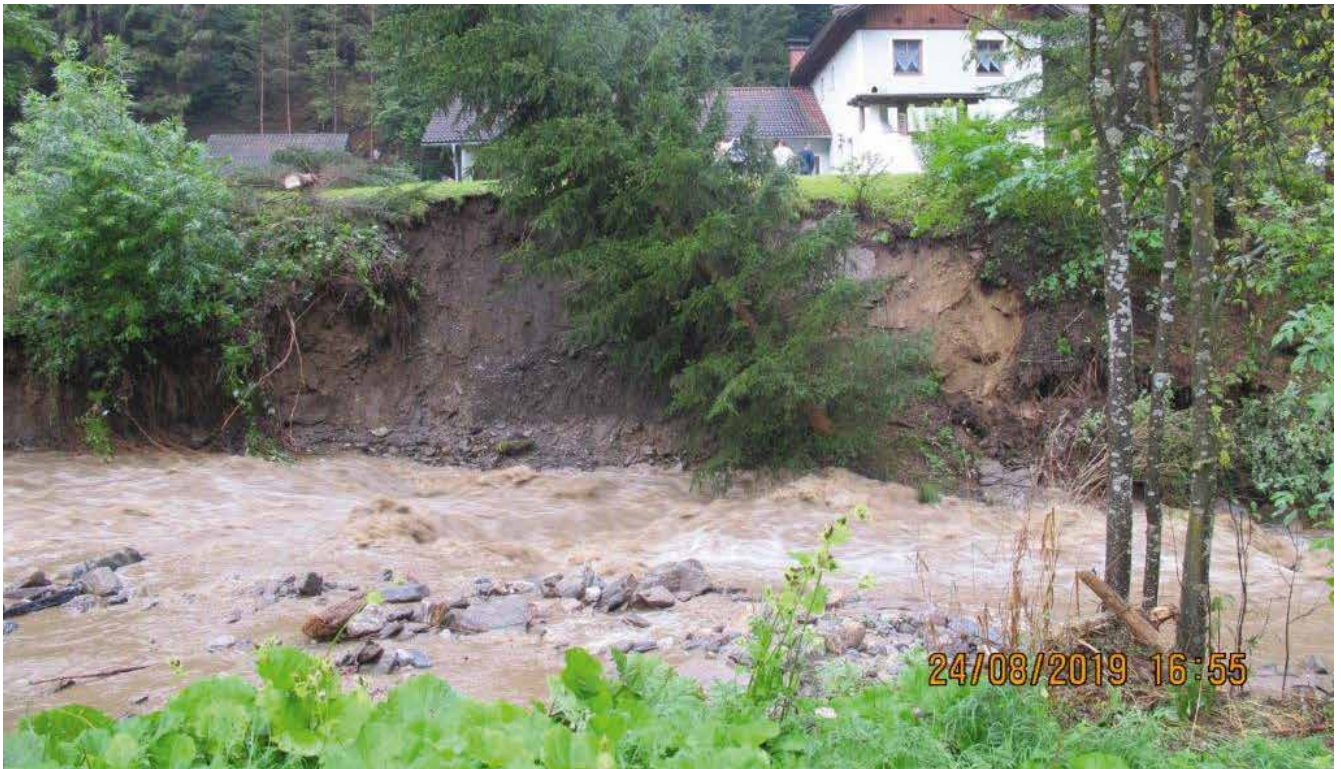
Abb. 4: Uferanriss und Gefährdung von Wohnobjekten an der Lavant © BBL OW
