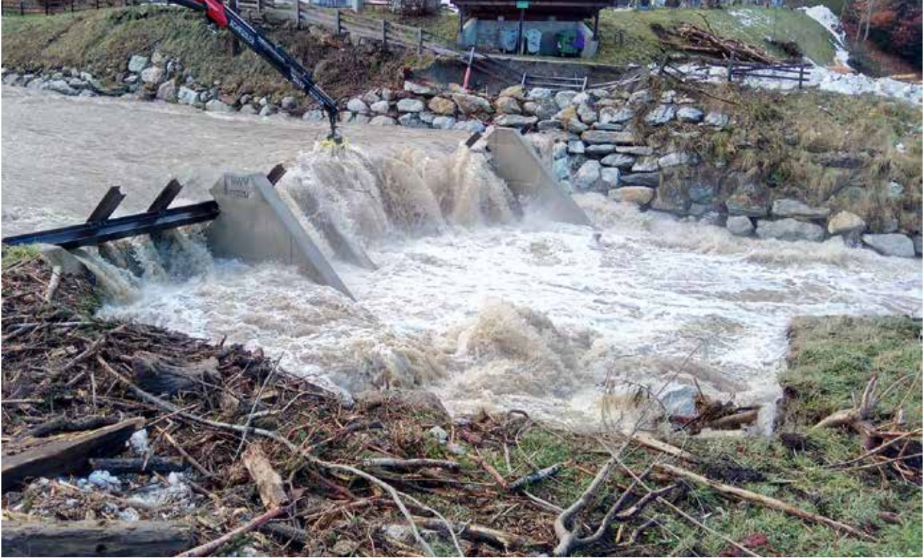
Abb. 7: Bestehende Hochwasserschutzmaßnahmen konnten größere Schäden verhindern © BBL OW
