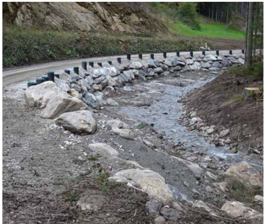
Abb. 5a und 5b: Lavant, Gemeinde Obdach, Zerstörung der Gemeindestraße durch Seitenerosion (oberes Bild) und nach der Wiederherstellung (unteres Bild) © WLV
