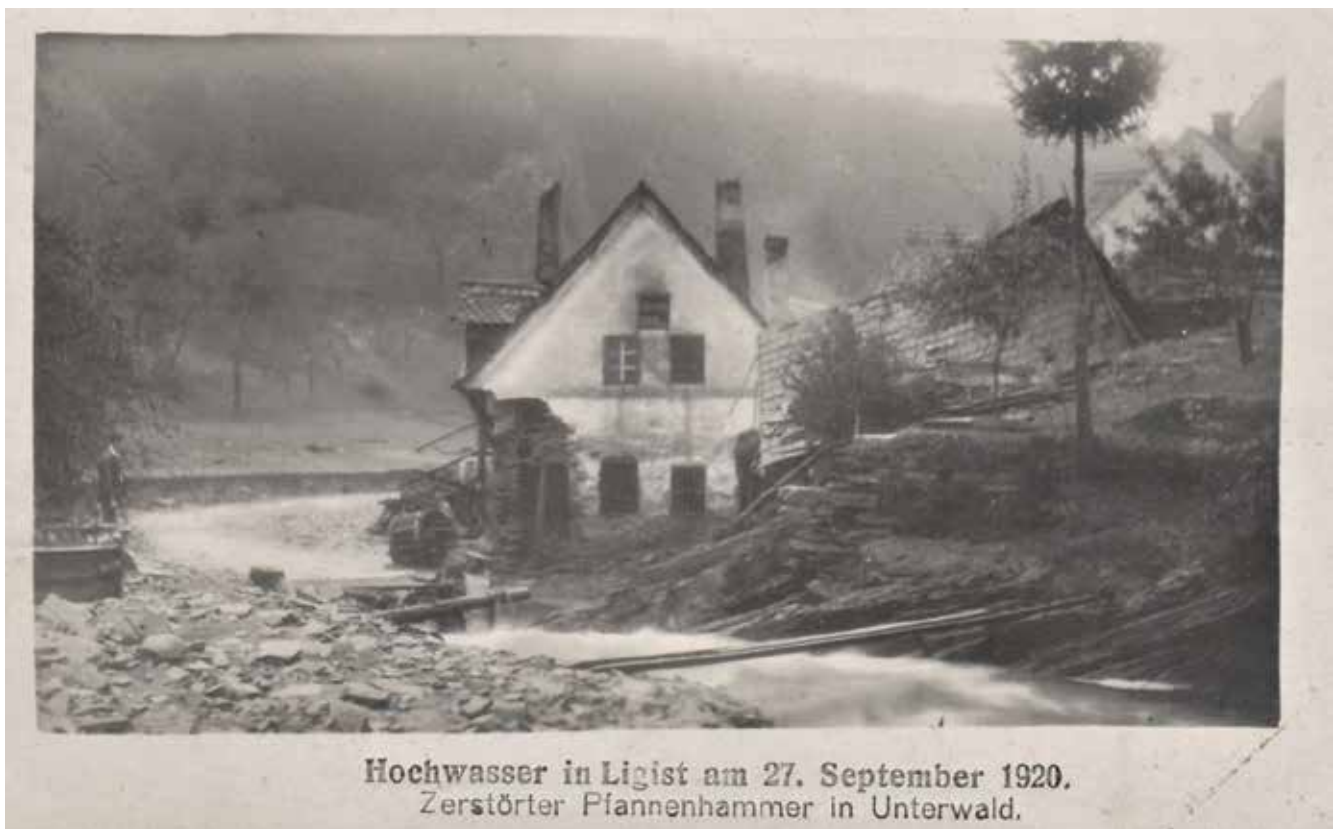
Abb. 4: Segen und Fluch der Wasserkraft lagen oft eng beieinander: Fotografie des durch ein Hochwasser im September 1920 zerstörten Pfannenhammers in Unterwald bei Ligist © Sammlung Reismann
