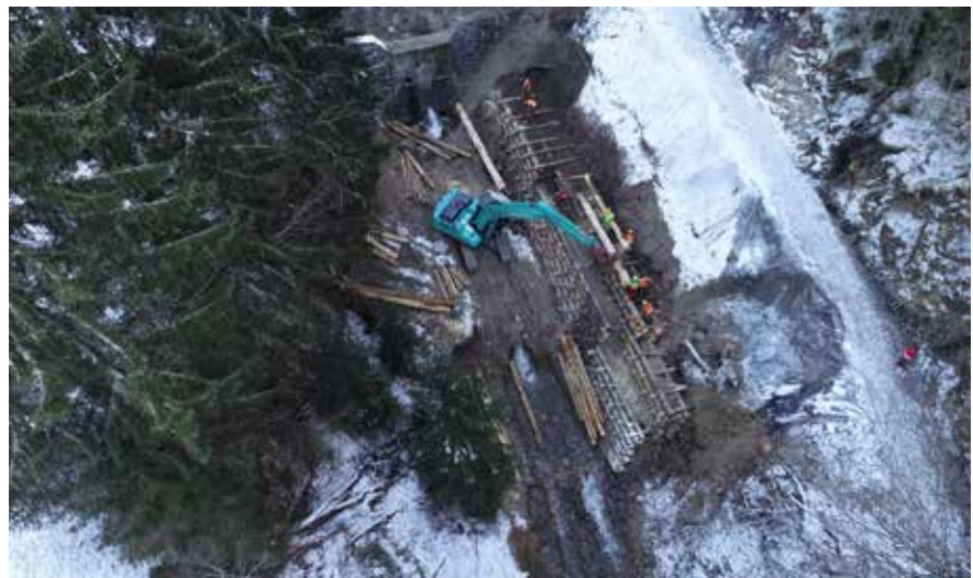
Abb. 9: Allgaubach, Gemeinde St. Georgen am Kreischberg, Errichtung einer Krainerwand im Zuge des Bundesheer-Assistenzeinsatzes © WLV
