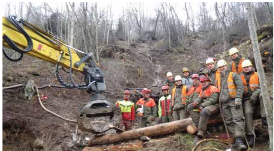
Abb. 10: Tschepbach, Gemeinde Stadl-Predlitz, Rutschungsstabilisierung durch Errichtung von Steinkastensperren © WLV
