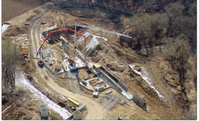
Rückhaltebecken Gammlitzbach in Bau, April 2005 Quelle: Zepp-cam Furian&Seidl OEG
