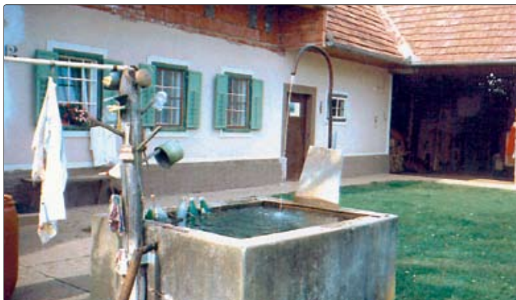
Linke Abb.: Artesische Bohrung mit freiem Überlauf
