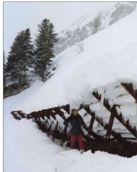
Detail eines Lawinestützwerks im Winter
