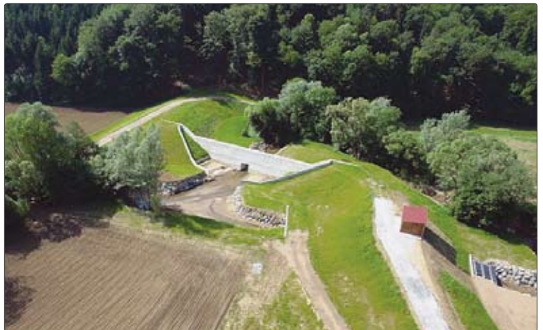
Rückhaltebecken Gammlitzbach fertig gestellt, Mai 2006 Quelle: Zepp-cam Furian&Seidl OEG
