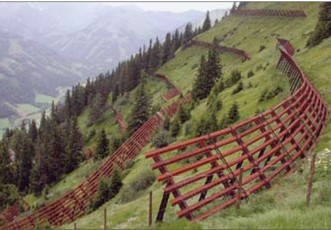
Lawinstützverbauung in Pusterwald
