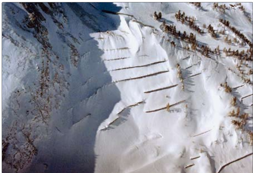
Lawinestützverbauung in Stahl im Anbruchgebiet
