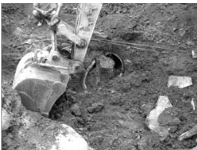
Abb. 1: Bauarbeiten am Zusertalgerinne im Frühjahr 2007
