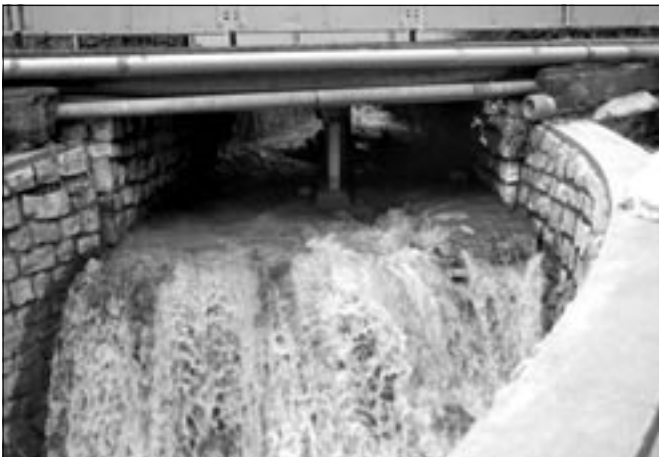
Rettenbach – Zubringer zum Mariatrosterbach. Die Sohlschwelle soll abgesenkt und organismenpassierbar gemacht werden.
