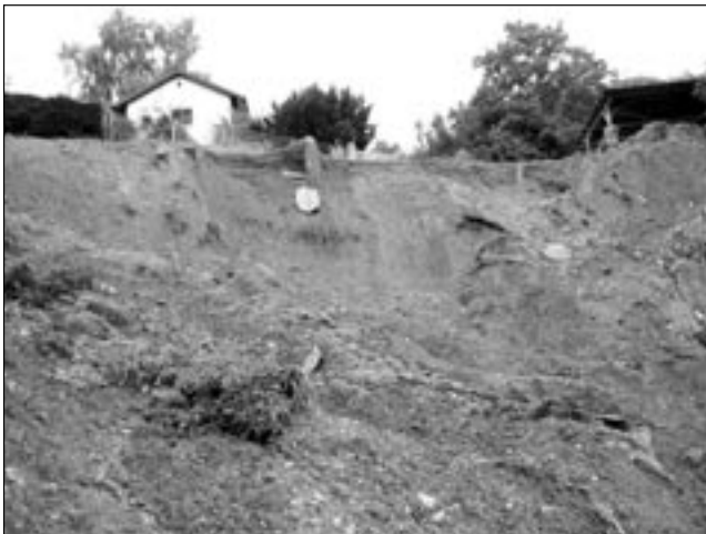
Rutschung im Dürrgrabenbach, August 2005
