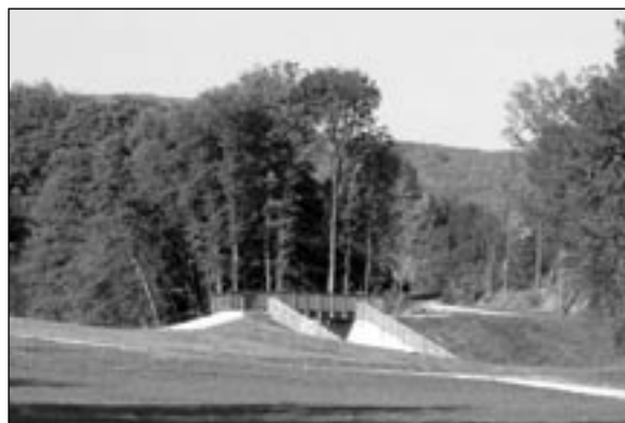
Abb. 2: Hochwasserschutzmaßnahme Gabriachbach, Rückhaltebecken II „Am Eichengrund“
