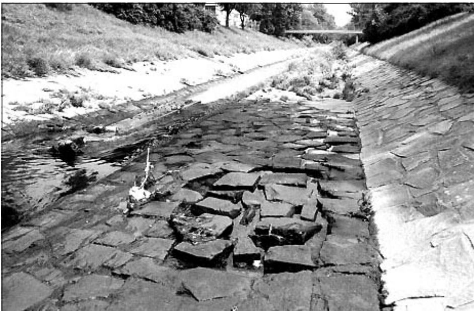
Liesing 1999 bei der Kästenbaumgasse vor Beginn der Revitalisierungsmaßnahmen.
