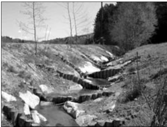
Erfolgreicher Rückbau einer Sohlschwelle
