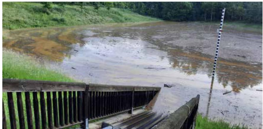
Abb. 1: Einstau Rückhaltebecken Kroisbach, Verklauung Grundablass © BWV Steiermark
