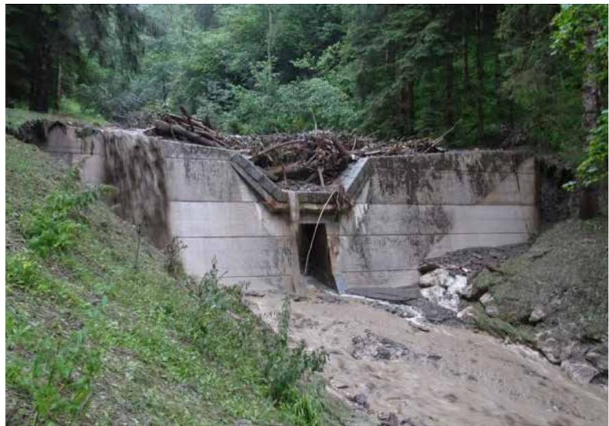
Abb. 4: 04.07.2022, Geschiebe- und Wildholzrückhalt durch die Geschiebesperre am Mitterreggergraben, Gemeinde Öblarn © WLW
