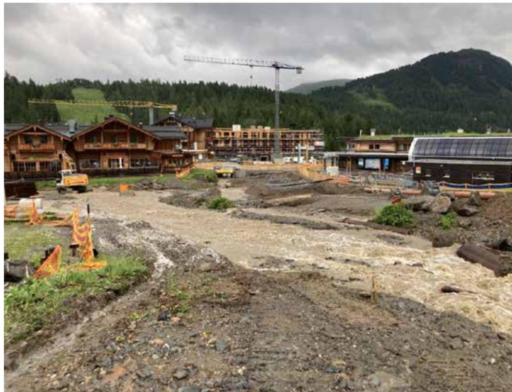
Abb. 7: Kornockbach - Hochwasserbeaufschlagung des im Bau befindlichen Verbauungsprojektes der Wildbach- und Lawinerverbauung, Gemeinde Stadl-Predlitz © WLW
