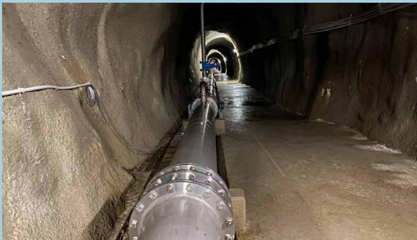
Abb. 3: Der Transport des Wasser vom Hochschwab erforderte auch den Bau von Stollen (hier Lercheckstollen) © Markus Petz
