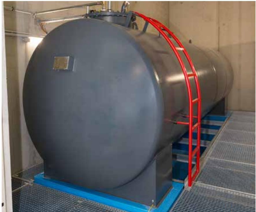
Abb. 2: Dieselspeicher der Tankanlage © LFWV GmbH
