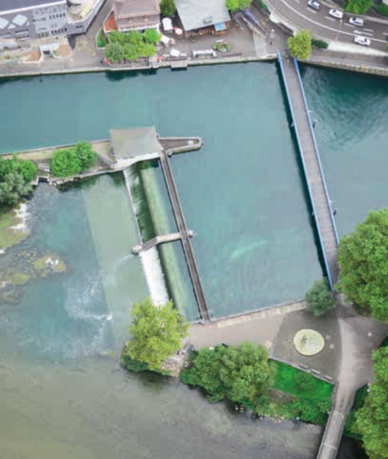
Abb. 7: Lettenwehr – Wehranlagen regulieren die Wasserstände. © AWEL, Kt. Zürich
