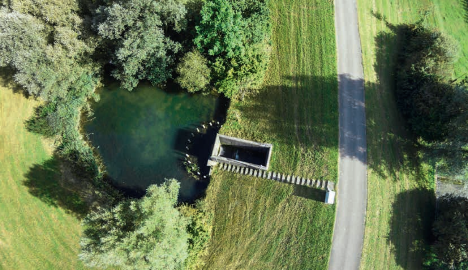
Abb. 9: Hochwasserrückhaltebecken Chatzenbach © AWEL, Kt. Zürich
