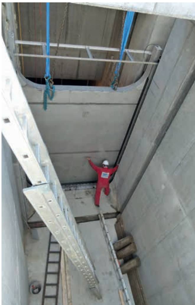
Abb. 2: Kaskadenbauwerk, Montage © Holding Graz
