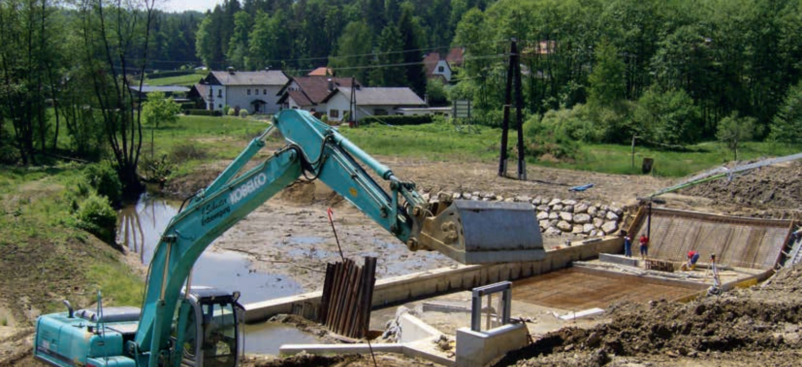
Abb. 4: Der Ausbau von Hochwasserschutzanlagen schützt Mensch und Infrastruktur und bringt Beschäftigung. © A 14
