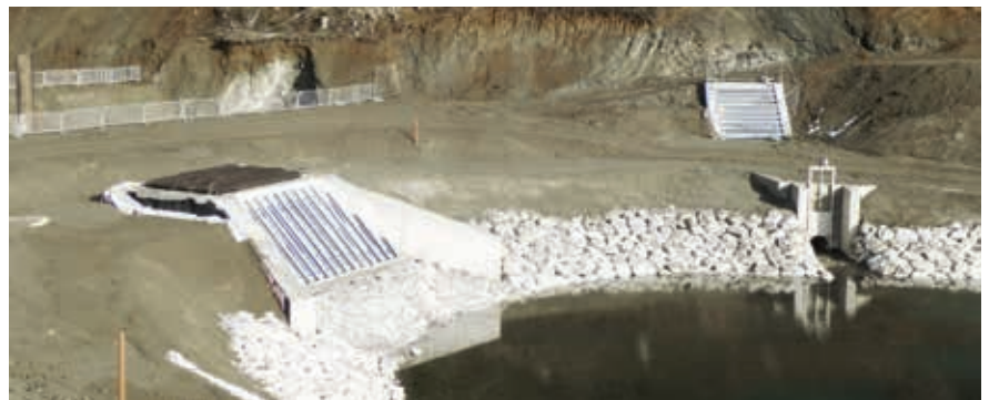
Abb. 2: Bauphase 2015, Einlaufbauwerk Grundablass, Bypass einlauf © WLV
