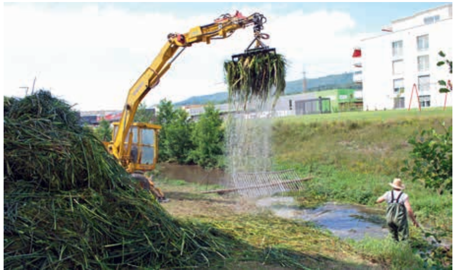
Abb. 3: Regelmäßiges Mähen von Bach- und Flussböschungen sind wichtige Arbeiten. © AWEL, Kt. Zürich
