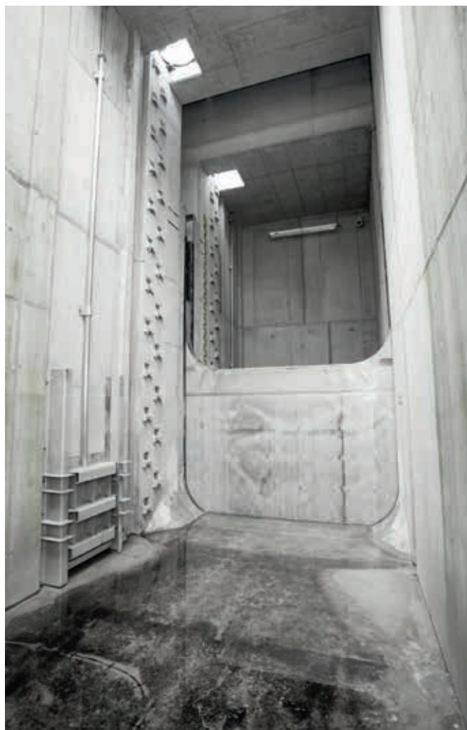
Abb. 3: Kaskadenbauwerk im Endzustand © Foto Fischer
