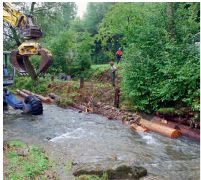
Abb. 2: Pflege- und Unterhaltsmaßnahmen dienen dem Hochwasserschutz. © AWEL, Kt. Zürich
