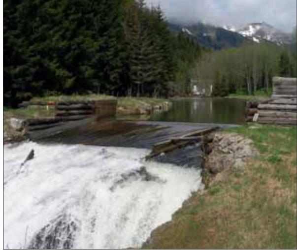
Wehranlage Kleinwasserkraftwerk Authal Foto UBZ
