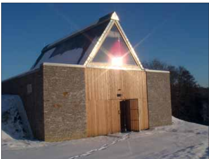
Abb. 4: Zentrales Bauwerk der Transportleitung, der Hochbehälter Laßnitzhöhe
