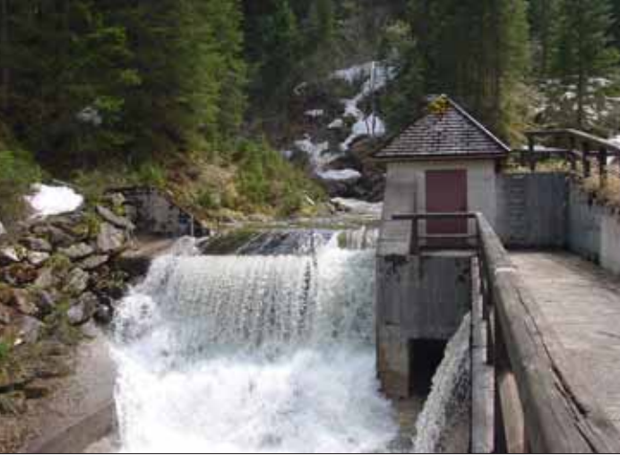
Wehranlage Kleinwasserkraftwerk Walchenbach Foto UBZ
