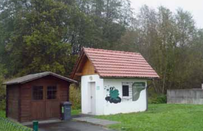
Abb. 8: Kläranlage der Abwassergenossenschaft Tobis in der Gemeinde St. Josef in der Weststeiermark
