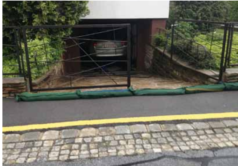
Abb. 4: Typische Garagenabfahrt in der Glesingerstraße mit Asphaltwulst und Sandsäcken als Hochwasserschutzmaßnahmen während des Regenereignisses am 03.07.2012.
