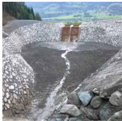
Abb. 5: Schwarzenbach: Stadtgemeinde Trieben, Geschieberückhaltebecken
