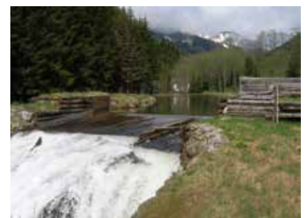
Abb. 3: Wehranlage Kleinwasserkraftwerk Auhall; © Otmär Winder
