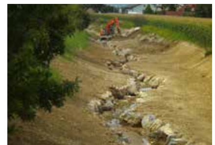
Abb. 2: Petersbach (Baustelle 2014) © Abteilung 14
