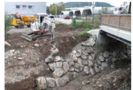
Abb. 1: Baumaßnahmen am Andritzbach (Baustelle 2014) © Abteilung 14
