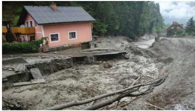
Abb. 1: Lorenzerbach: Stadtgemeinde Trieben, Haus Friedl nach dem Murgang
