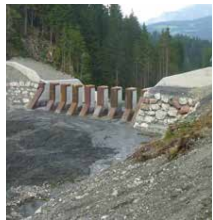
Abb. 4: Lorenzerbach: Stadtgemeinde Trieben, Murbrecher
