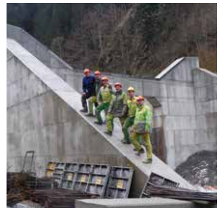
Abb. 6: Tobeitschbach: Gemeinde Gaihorn, Geschieberückhaltesperre in Bau
