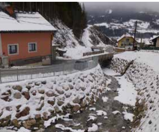
Stadtgemeinde Trieben, Haus Friedl nach der Sanierung
