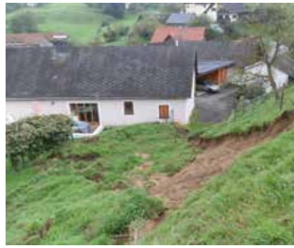
Abb. 4: Hangrutschungen verursachen massive Schäden und Kosten © Abteilung 14
