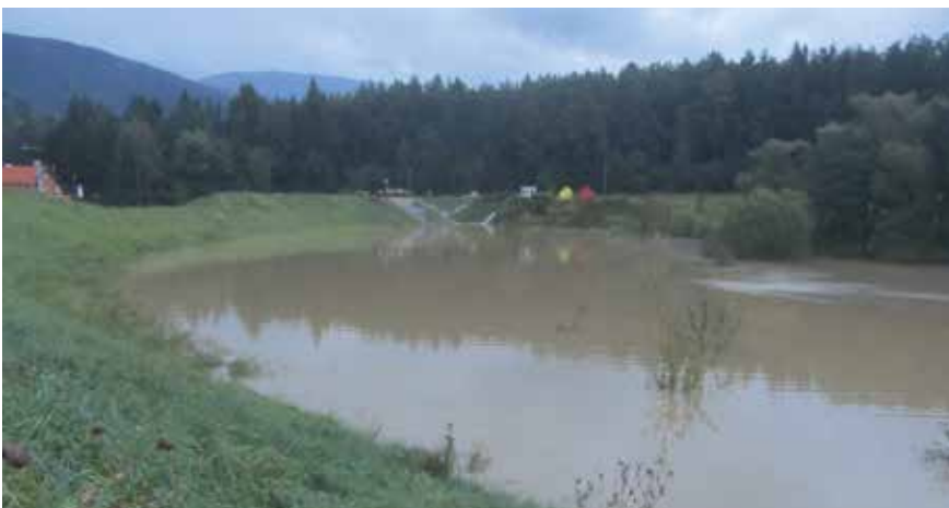
Abb. 6: Rückhaltebecken Schöckbach, Weinitzen zeigt Wirkung © jaunegg
