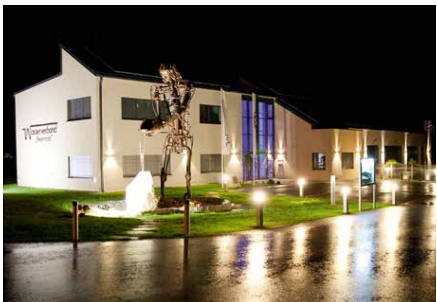
Verbandsgebäude Wasserverband Feistritztal © Martin Grabmayer, www.fotospass.at
