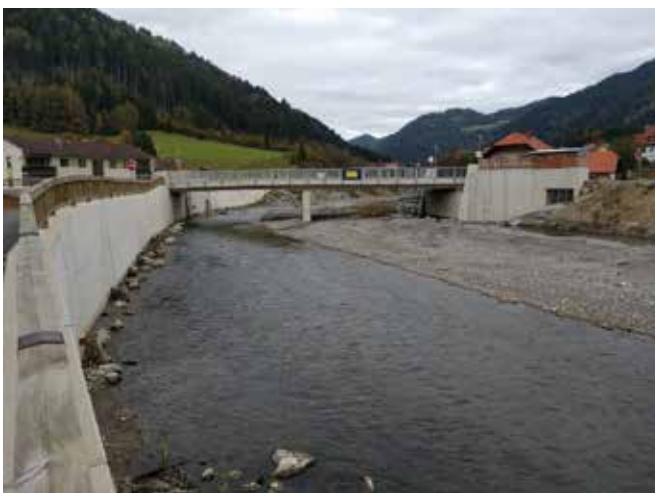
Fertiggestellte Linearmaßnahme am Wölzertal © A14
