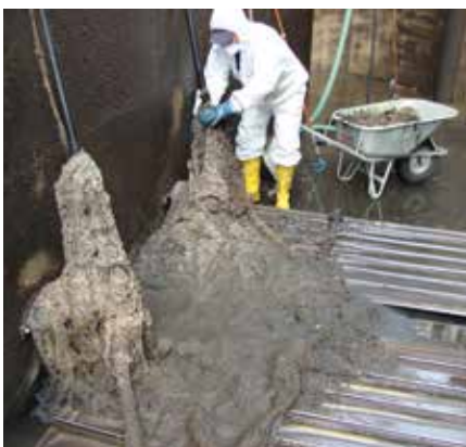
Verzopfungen entfernen im Belebungsbecken
