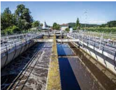
Abwasserreinigung erfolgt in den Belebungsbecken
