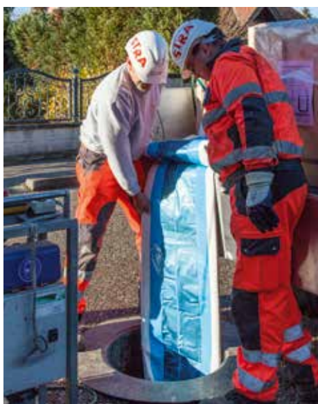
Effiziente Kanalsanierung im Mürztal durch grabenlose Verfahren © Fa. Strabag
