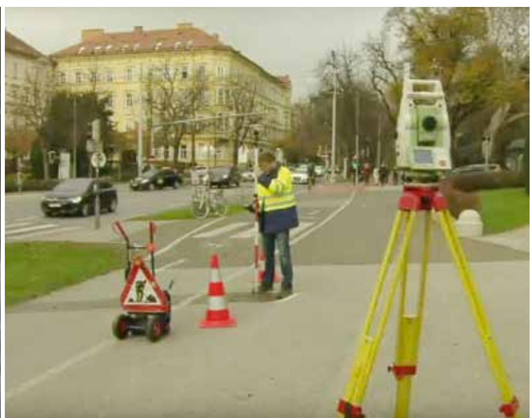
Vermessung der Kanalschächte der Stadt Graz durch Techniker © ORF-Beitrag Kanalkataster
