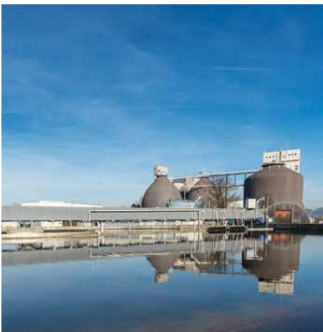
Kläranlage der Stadt Graz © Fischer
