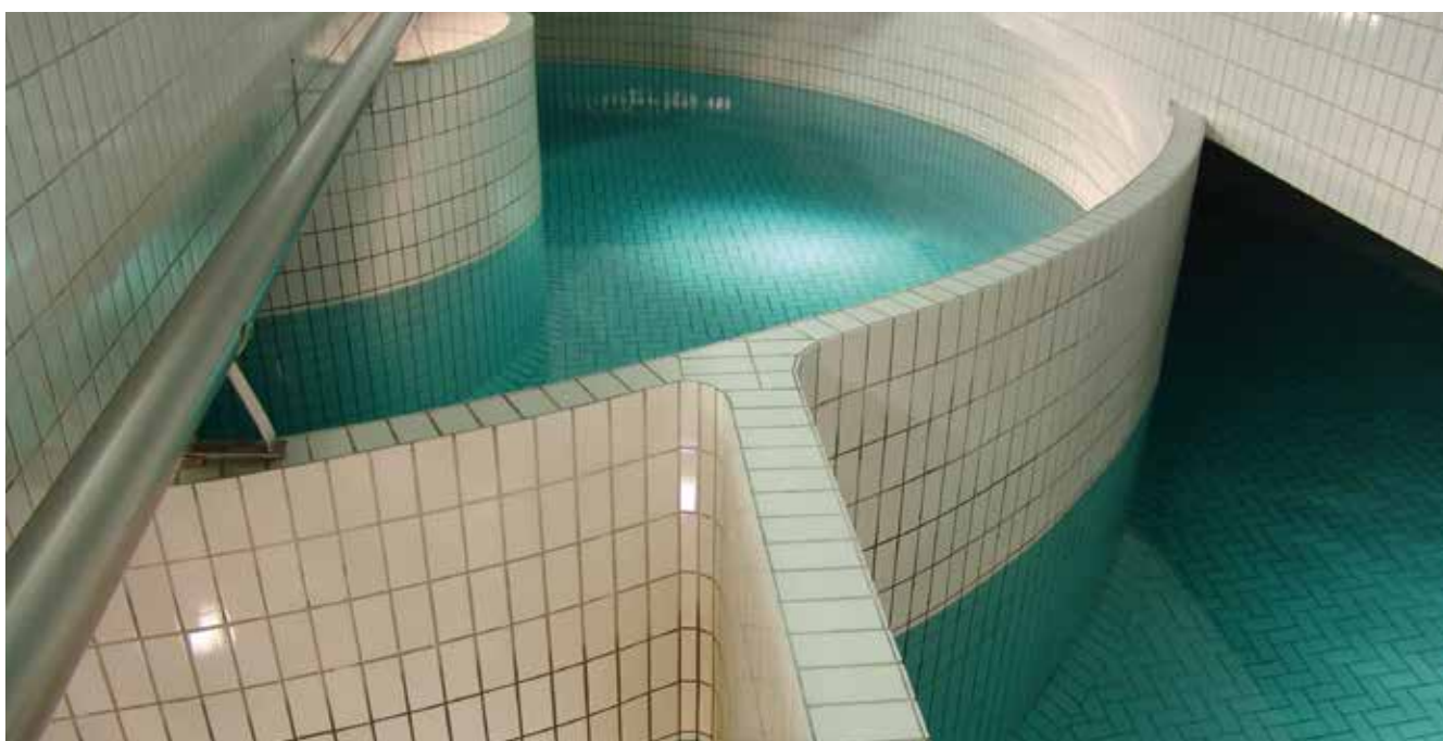
Wasserhochbehälter Leibnitz © Leibnitzerfeld Wasserversorgung GmbH
