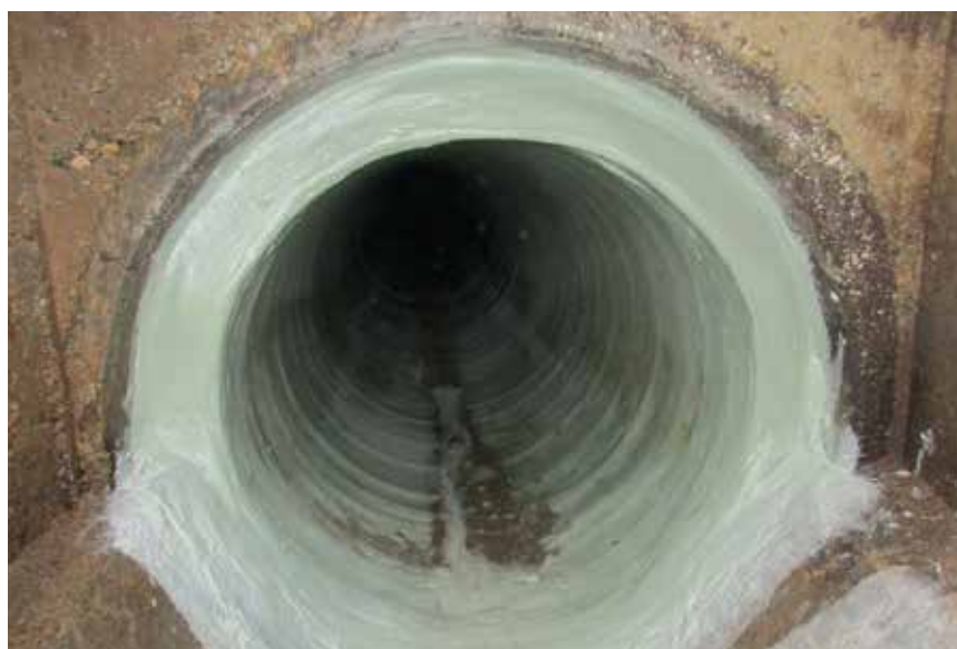
Kanalsanierung durch GFK Schlauchliner. Die Aushärtung erfolgt mittels UV-Lampenkette. © Mürzverband
