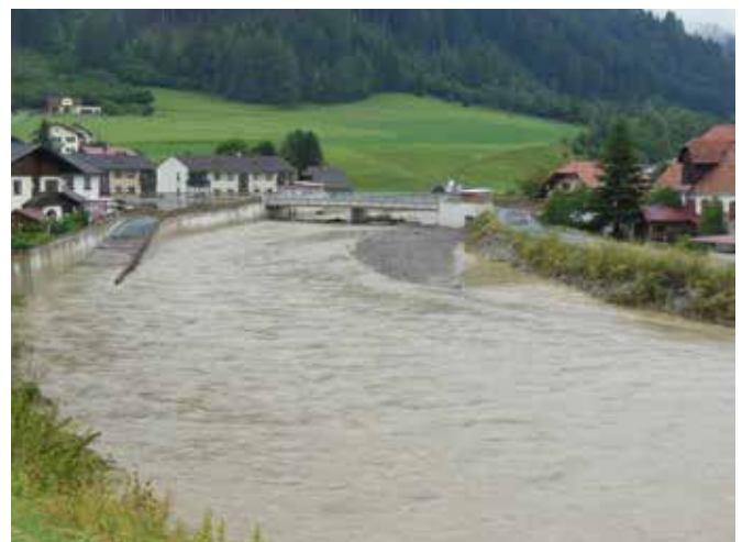
Wirkung der Linearmaßnahme in Niederwölz beim Hochwasserereignis 2017 © A14
