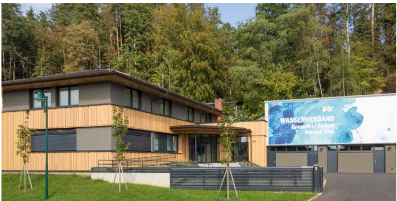
Das Verbandsgebäude des Wasserverbandes Grazerfeld Südost und Umland Graz in Hausmannstätten © movemus brand positioning
