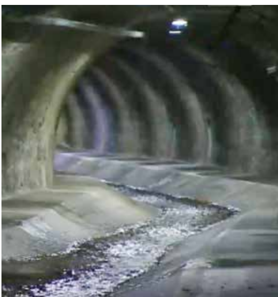
Kanalisation in Graz © ORF-Beitrag Kanalkataster
