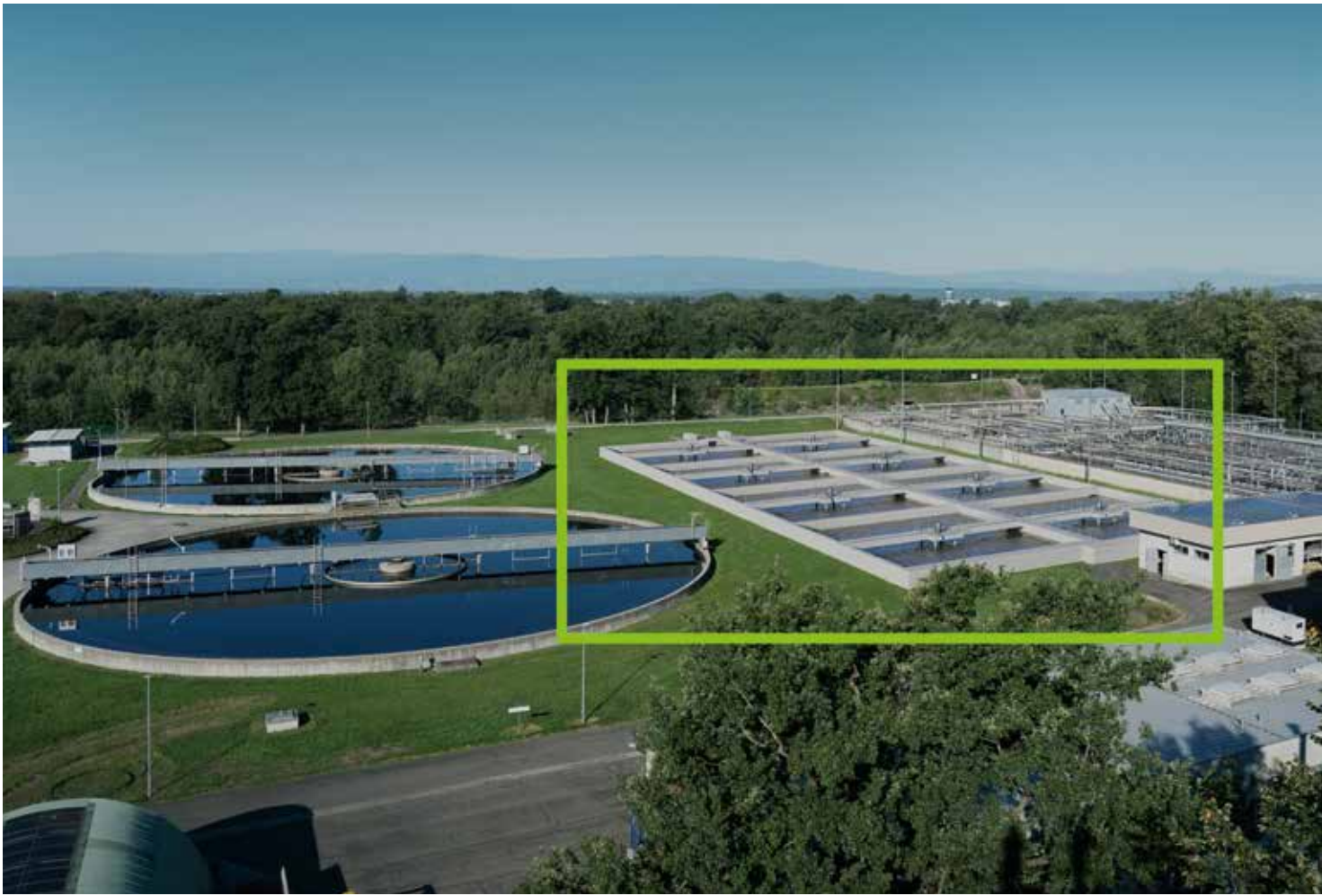
Abb. 2: ARA Graz – Fotomontage der Erweiterung der Belebungsbecken (siehe grüner Rahmen) © Holding Graz
