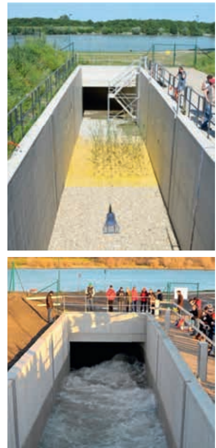
Abb. 5: Forschungsgerinne mit eingebauten ersten Versuchen, und bei Öffnung der Schützen
