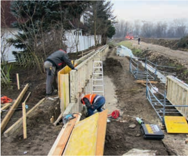
Abb. 3: Herstellung einer Hochwasserschutzmauer © BBL SZ
