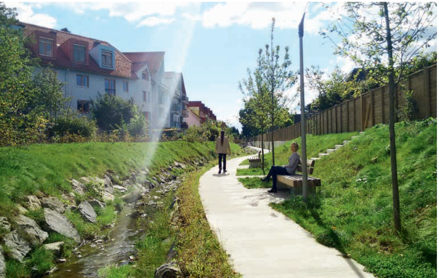
Abb. 2: Erholungsraum Petersbach nach dem Ausbau © BBL SZ
