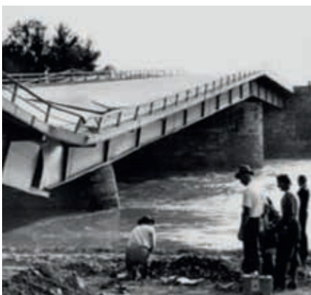
Abb. 1b: Beispiele für Sedimentdefizit: Sohldurchschlag (rechts) und Einsturz der Autobahnbrücke Liefering (links) an der Salzach vom 13.08.1969 (WRS, 2000)
