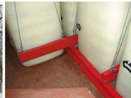
Verankerung von Tanks
