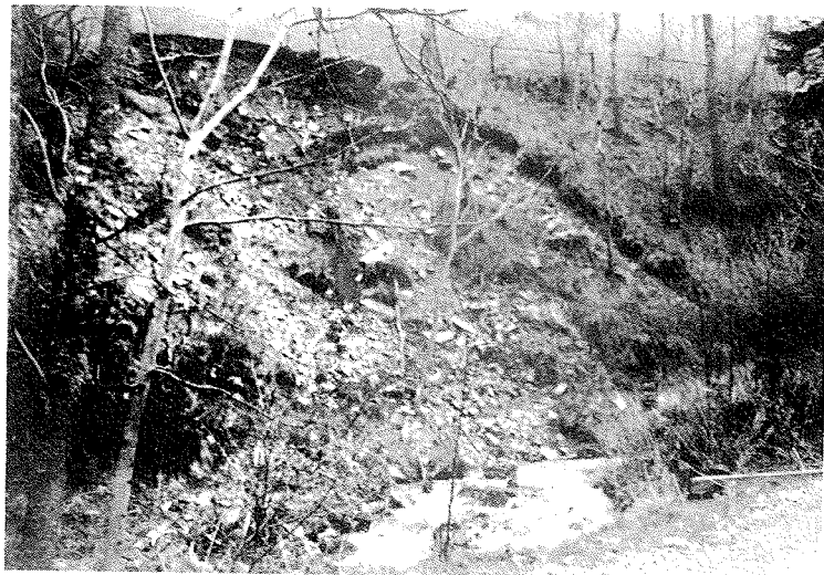
Abb. 27 Anriß bei der Grabenbiegung (Hangfußschutt)
