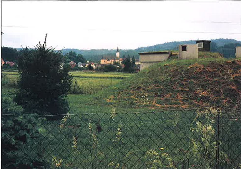
Abb. 5.1.3: Brunnenanlage und Schutzgebiet Gössendorf, Blickrichtung Süden
