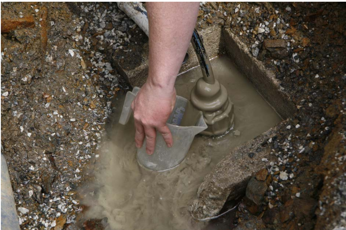
Abb. 46: Entnehmen der verpressten Suspension
