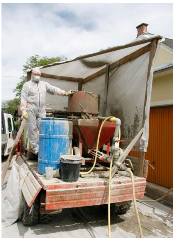
Abb. 39: Herstellen der Suspension
