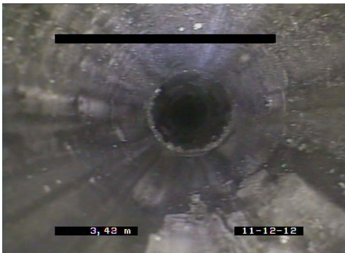
Abb. 24: Intakte Verrohrung
