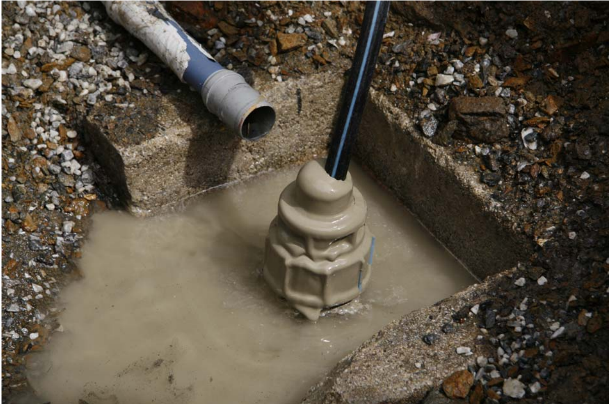
Abb. 45: Verpressen von unten nach oben - Ende
