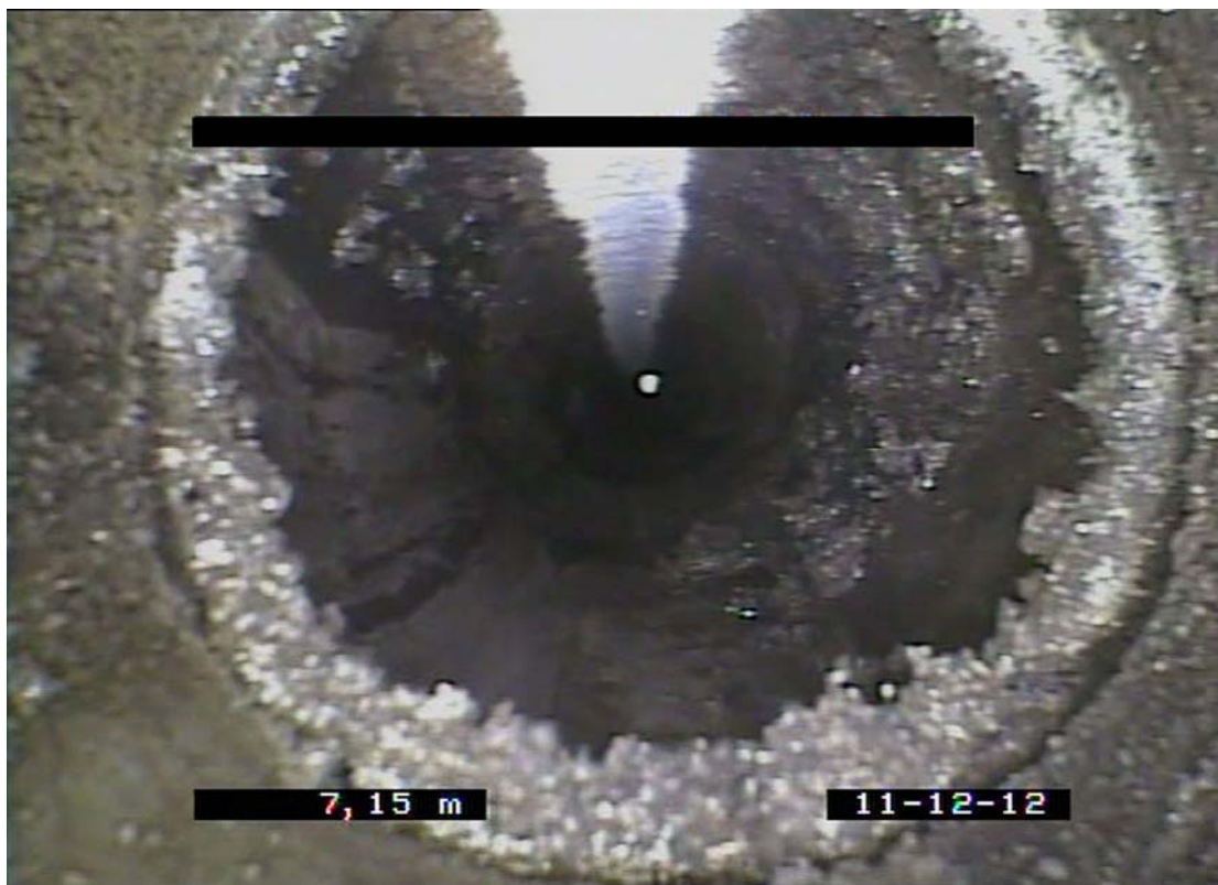
Abb. 27: Rohrverbindung mit Krustation
