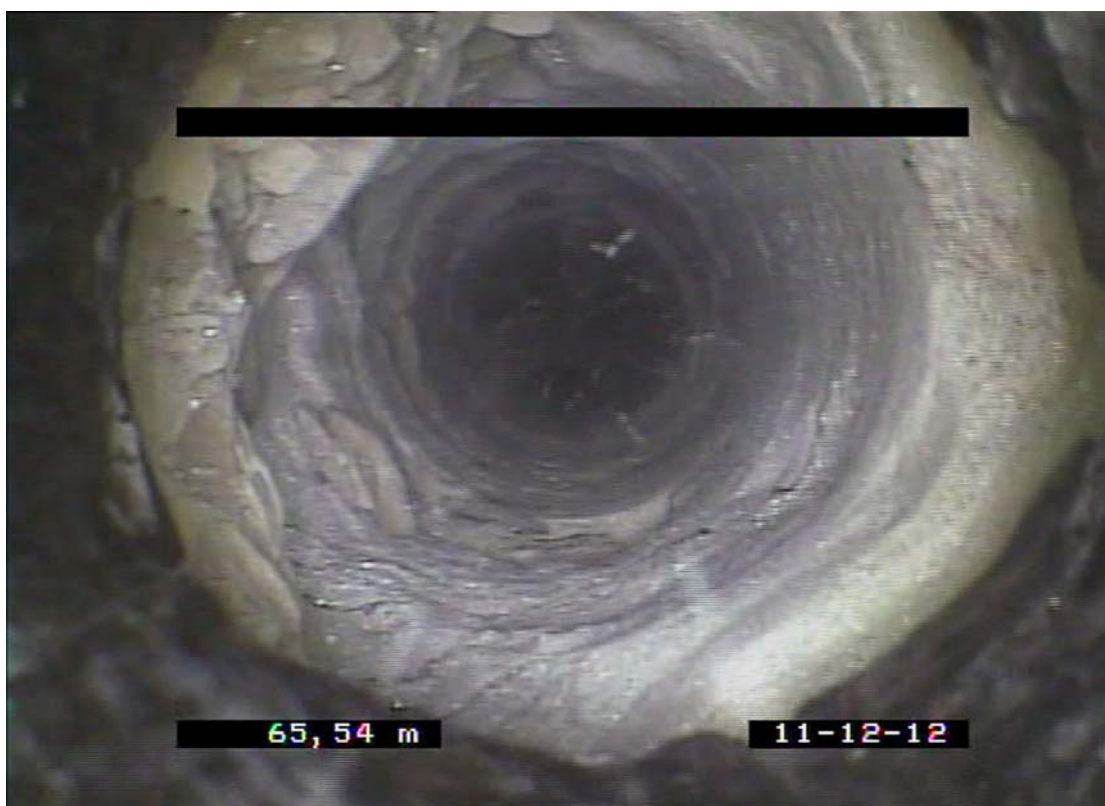
Abb. 28: Übergang verrohrtes Bohrloch – unverrohrtes Bohrloch
