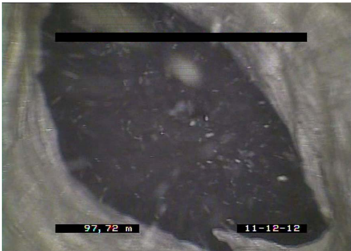
Abb. 32: Unverrohrtes Bohrloch (Endkaverne)
