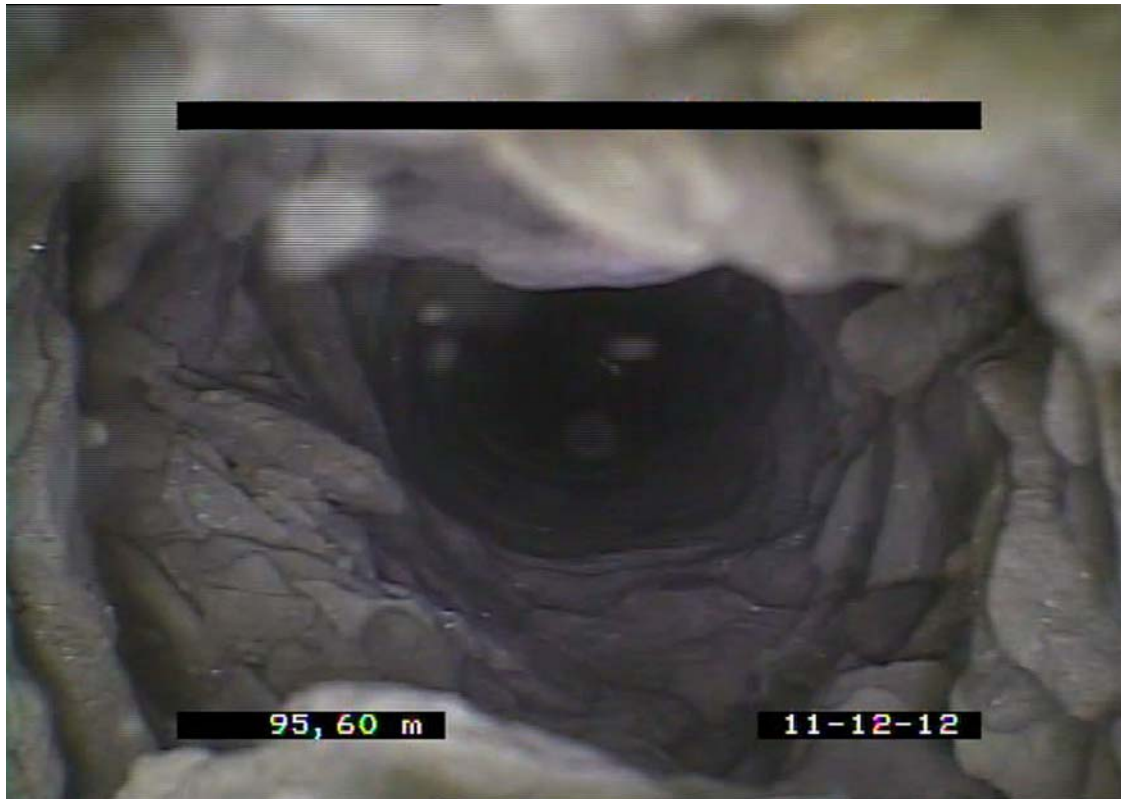
Abb. 31: Unverrohrtes Bohrloch (Verbruch)
