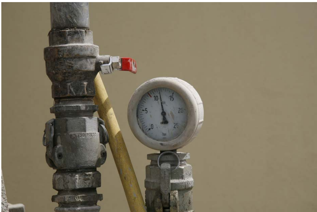
Abb. 49: Signifikanter Druckanstieg
