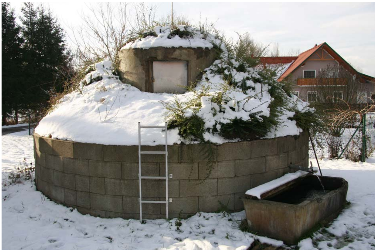
Abb. 15: Wasserbehälter mit Überlauf
