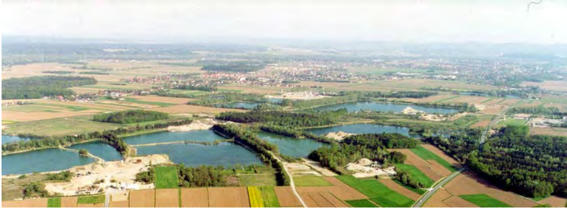
Fig. 14: „Badewannenartige“ Ausbildung der Baggerseen in dem die Schotteraufbereitungsflächen zusätzliche Störungen bedeuten.
