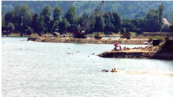
Fig. 17: Badenutzung an der Nassbaggerung Til 7. Südwestliche Blickrichtung.
