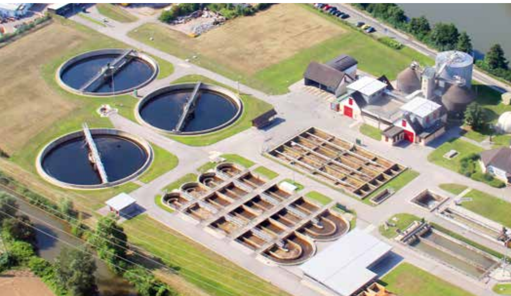
Abb. 3: Kläranlagen auf dem Stand der Technik leisten wichtigen Beitrag zum Gewässerschutz. © Land Steiermark
