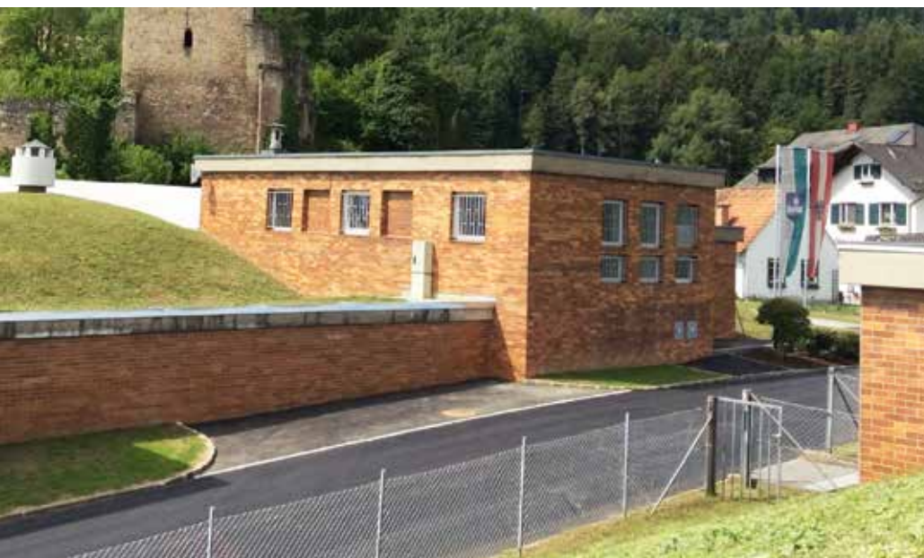
Abb. 1: Wasserversorgungsanlage in Sturmburg © W. Ederer – Stadtgemeinde Weiz
