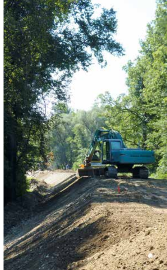
Abb. 2: Sanierung und Erhöhung des Murdamms © A14
