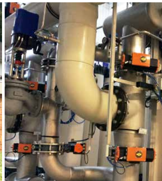
Abb. 2: Ultrafiltrationsanlage © W. Ederer – Stadtgemeinde Weiz
