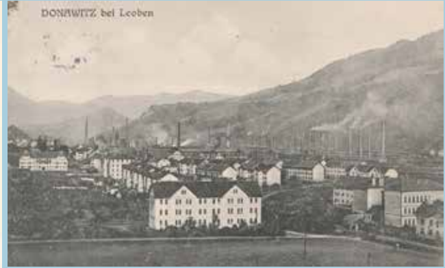
Abb. 2: Leoben-Donawitz, eine der am stärksten wachsenden Industriege- meinden des Landes im 19. Jahrhundert. Hier traten auch ernste Probleme mit der Abwasserentsorgung auf. 1910 wurde in Donawitz eine frühe, zentrale Kanalisationsanlage errichtet. © Sammlung Reismann
