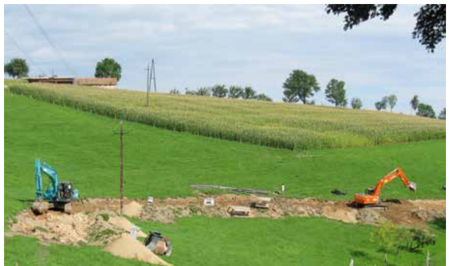
Abb. 1: Kanalbau im ländlichen Raum © GSA
