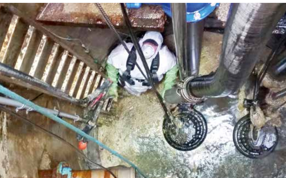
Abb. 3: Notwendige Reinigung des Pumpwerks wegen Verstopfung. © GSA
