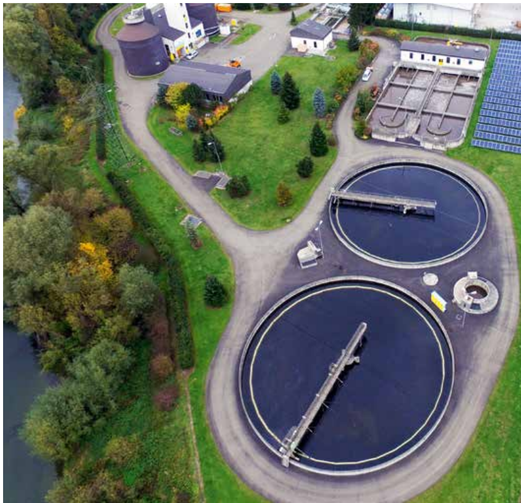
Abb. 2: Kläranlage Kapfenberg – Mürzverband © GSA
