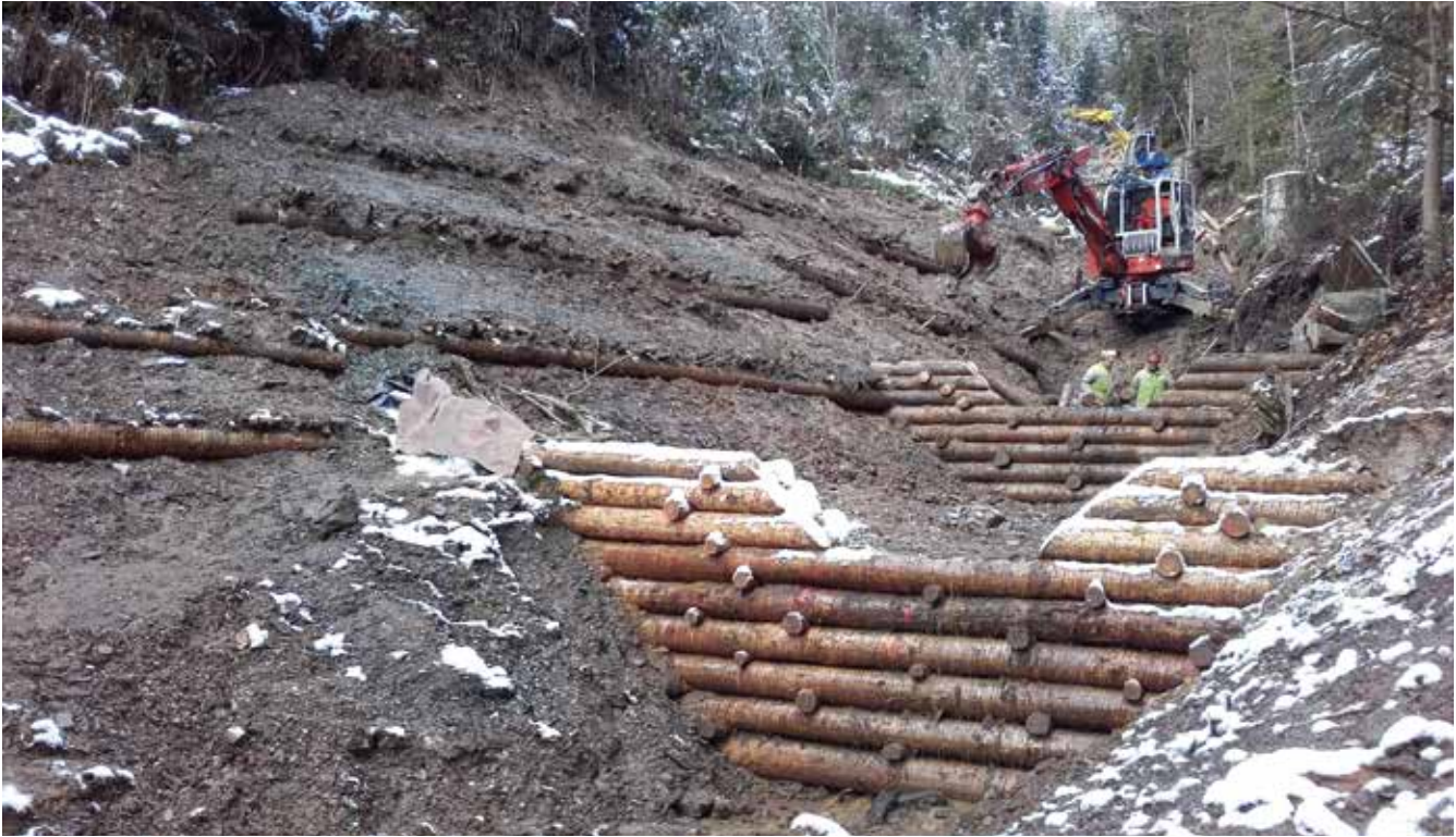
Abb. 7: Errichtung einer Grabenkonsolidierung mittels Holzkrainersperren im Grubbauergraben während der Hochwasserkatastrophenbewältigung 2016 © WLW
